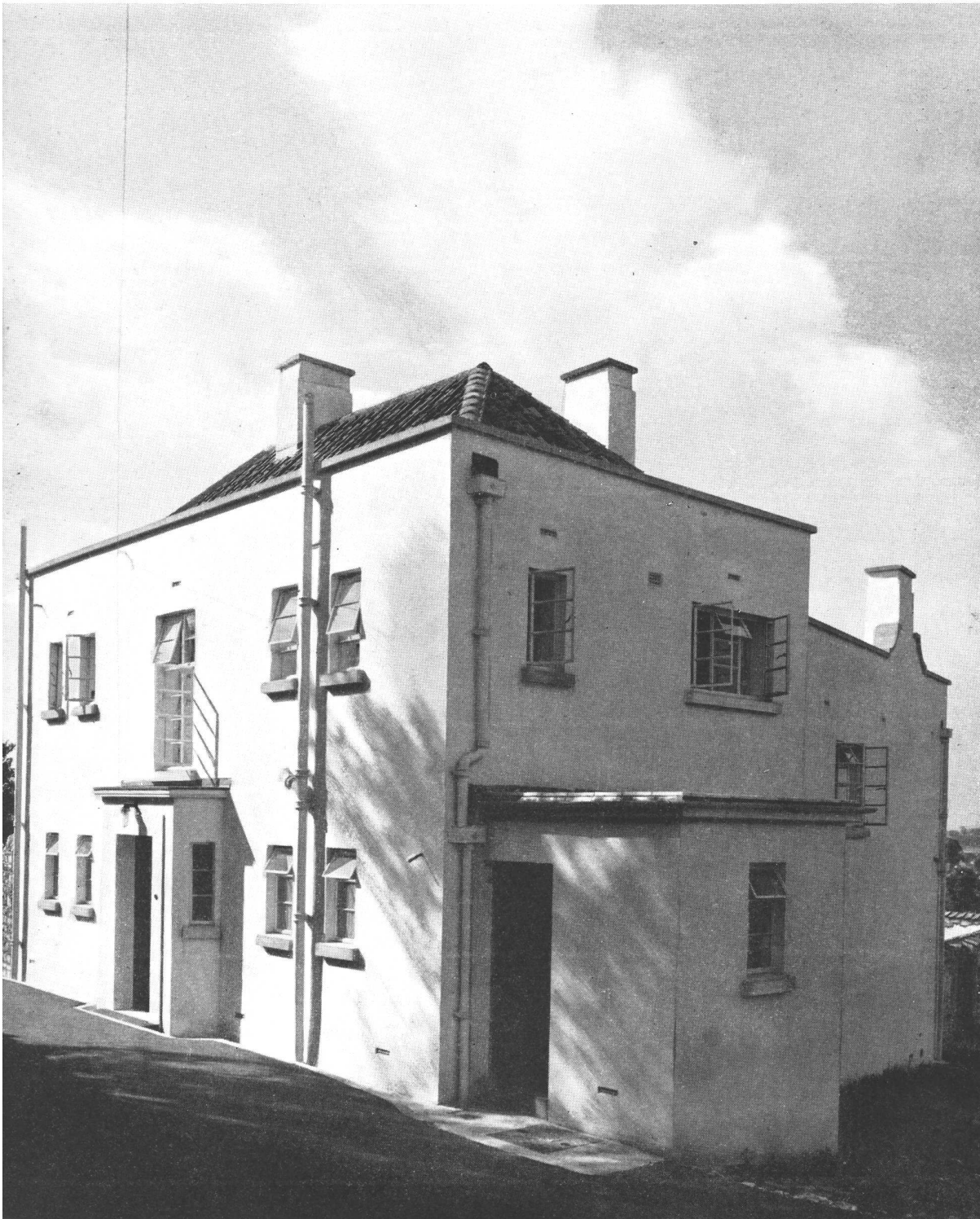
"Little Grange" vista desde la calle; llaman la atención los caños de desagüe, que en típica forma de construcción inglesa se ubican exteriormente.
