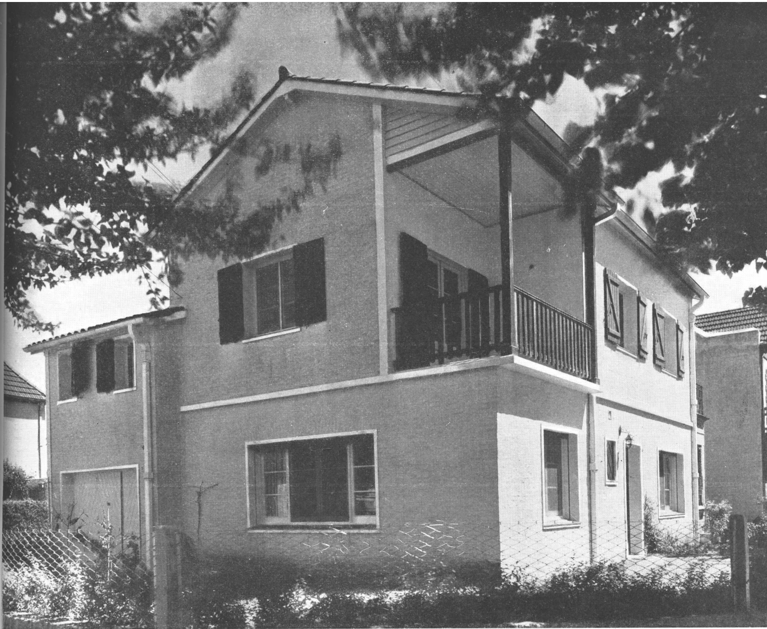
La casa, ubicada en la esquina de las calles Rawson y Sáenz Peña, tiene la fachada de ladrillos aparentes con junta desparramada, pintados a la color beige. Mochetas de aberturas revocadas de blanco.
