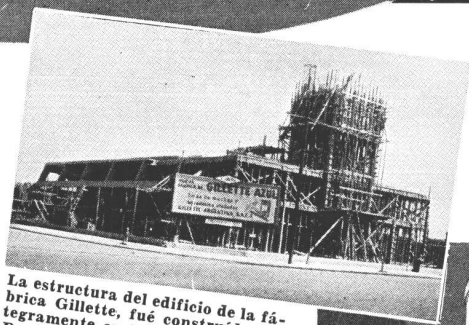
Un detalle de la chimenea del establecimiento, construida íntegramente de hormigón de cemento portland. La altura total de esta chimenea es de 25 metros
