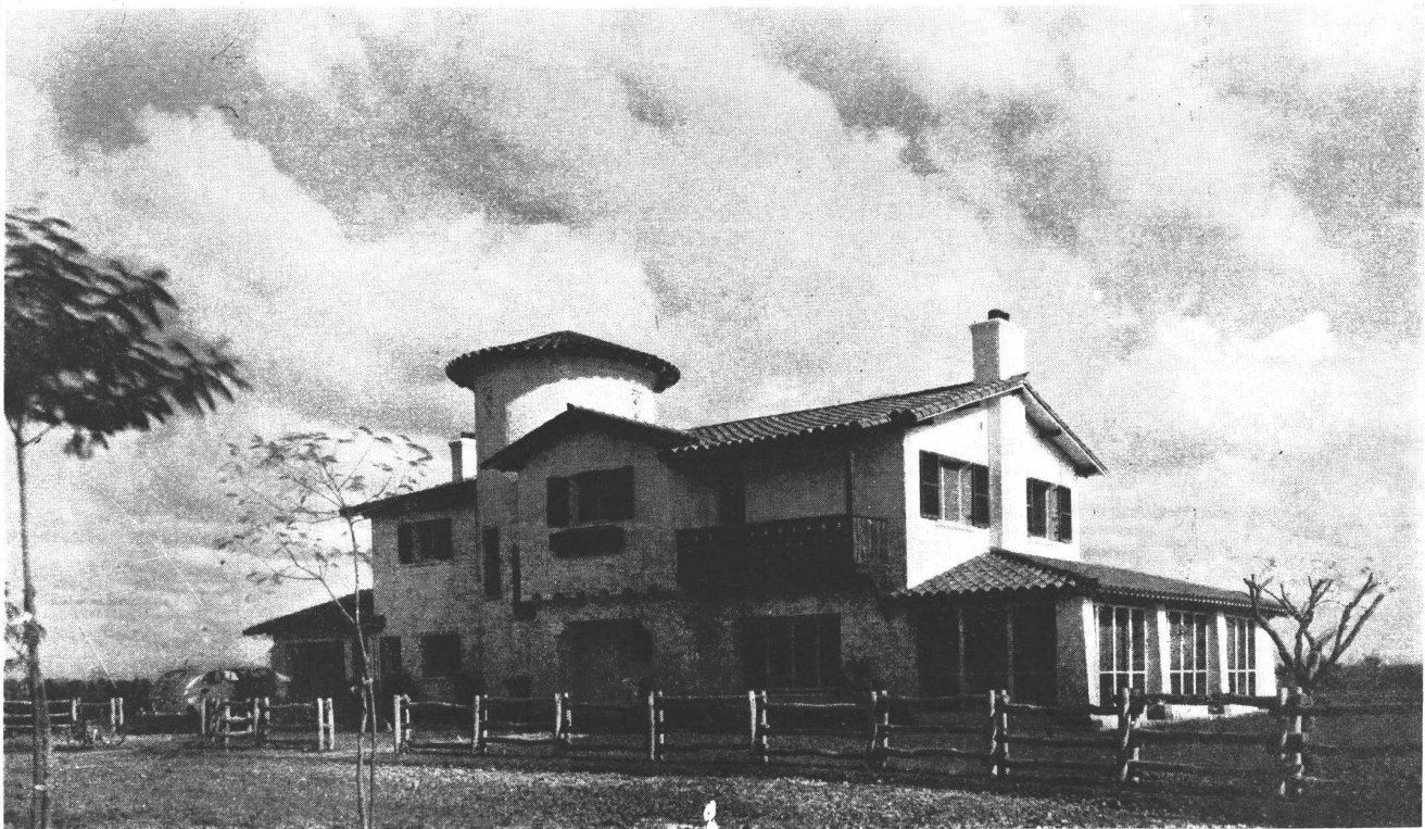
Fachada Norte; vista de conjunto. Revoque rústico blanqueado en fresco. Madera dura a la vista, hachuelada.
