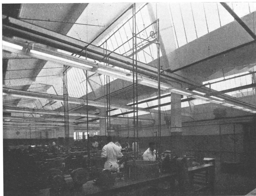
Dos vistas de la fábrica, en que se aprecian las perfectas condiciones en que trabajan los obreros.
