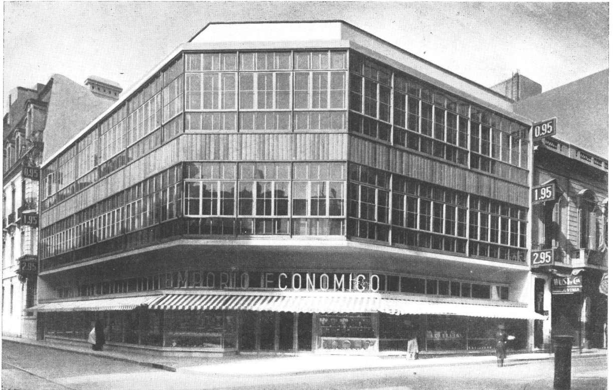
Edificio para negocio, Viamonte y Florida. - Arq.: Sr. Alberto Prebisch. - Const.: Sres. F. Natino e Hijos. Hormigón: Sres. Hulskamp y Baldas
