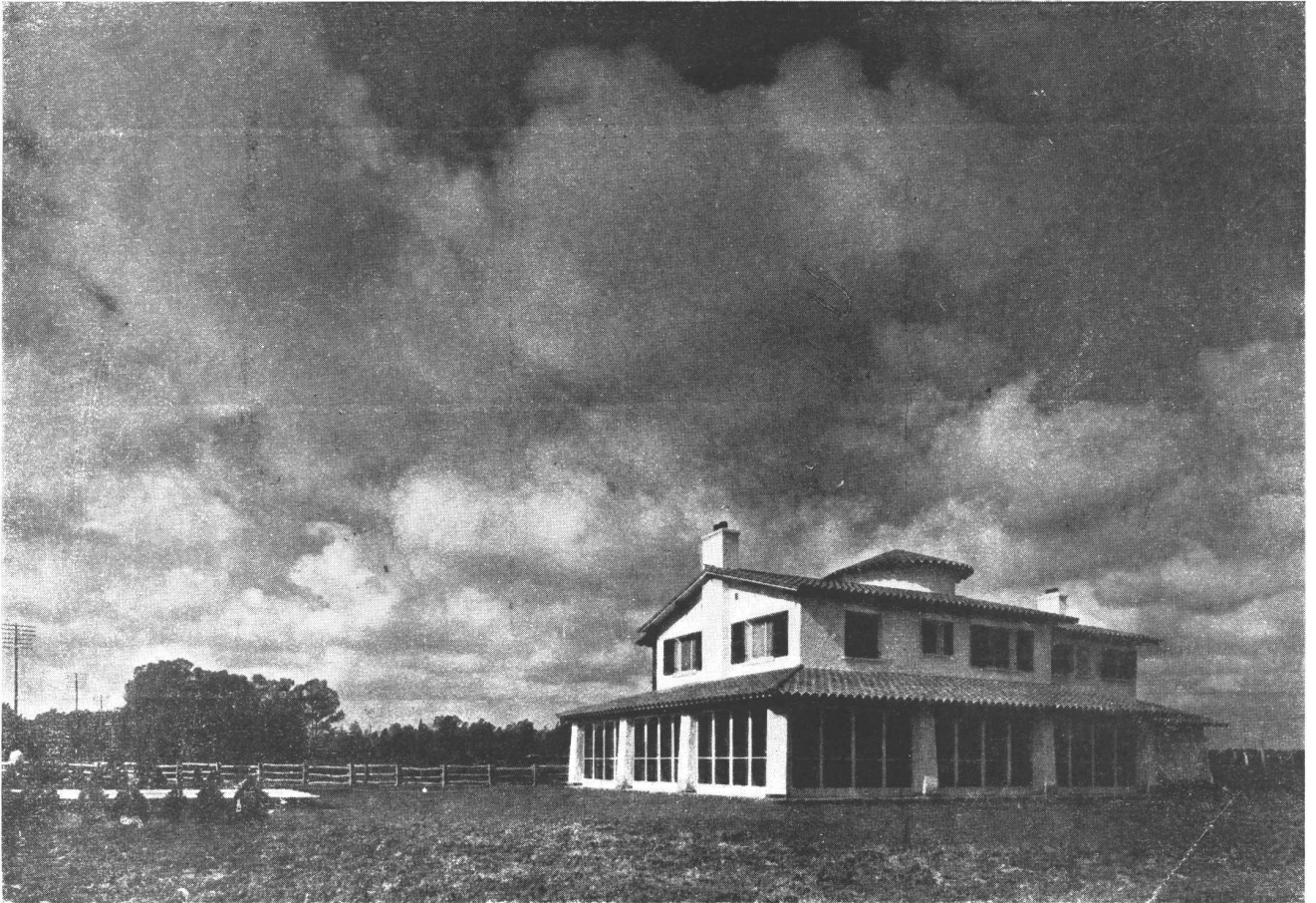
Una vista general de la casa, propiedad de la Sra. María Antonia Belaústegui de Cullen Paunero. La galería, que se extiende a dos frentes, está reparada con mosqueras. Cerca de madera rústica, pequeña pileta para los niños. Construida por Antonio R. Lanusse, Ing. Civ. Plantaciones por los Ings. Neira y Ezcurra.
