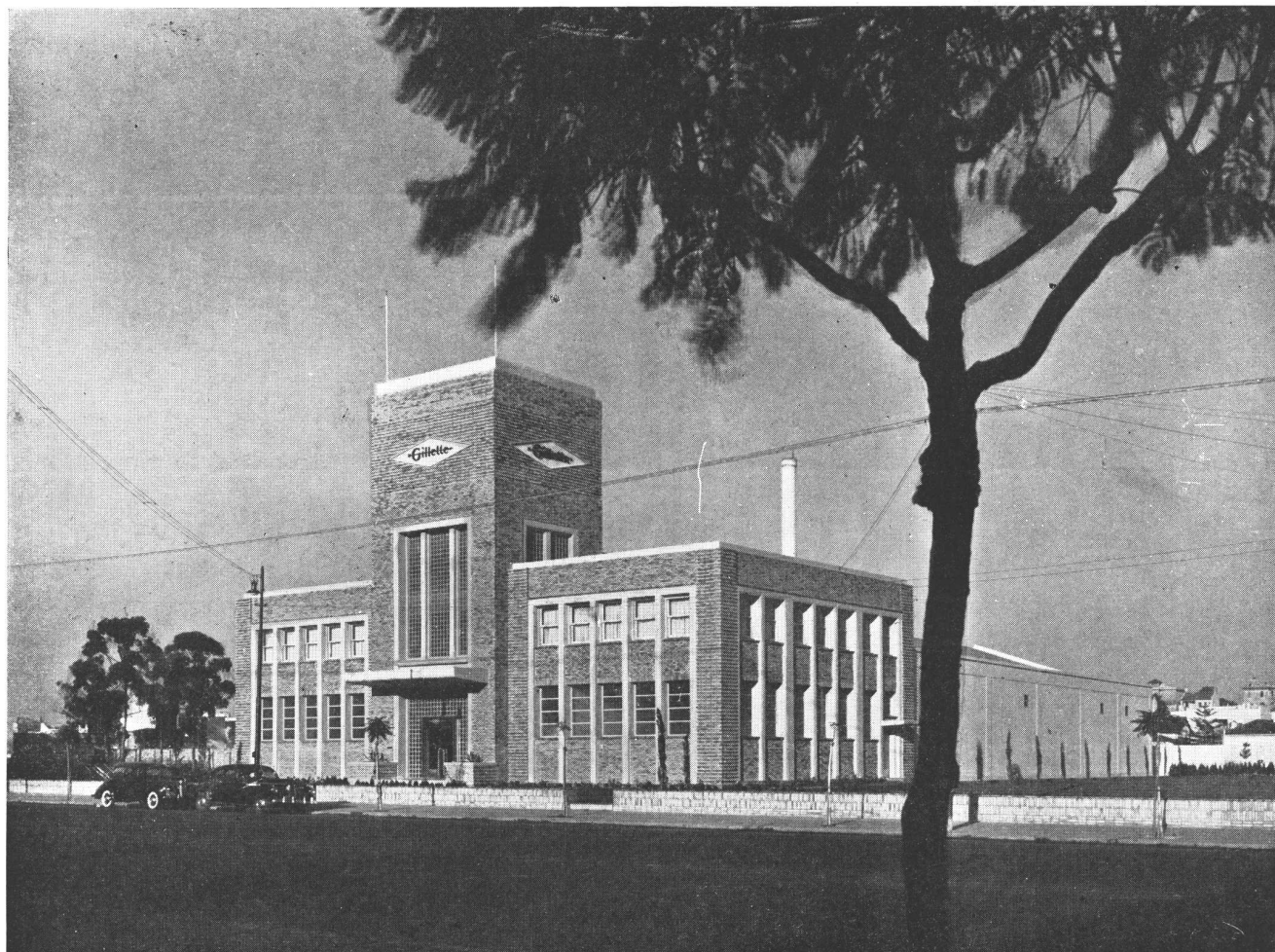
Fachada principal y una de las laterales del edificio para fábrica y oficinas de "Gillette Argentina S. A. C. I."
