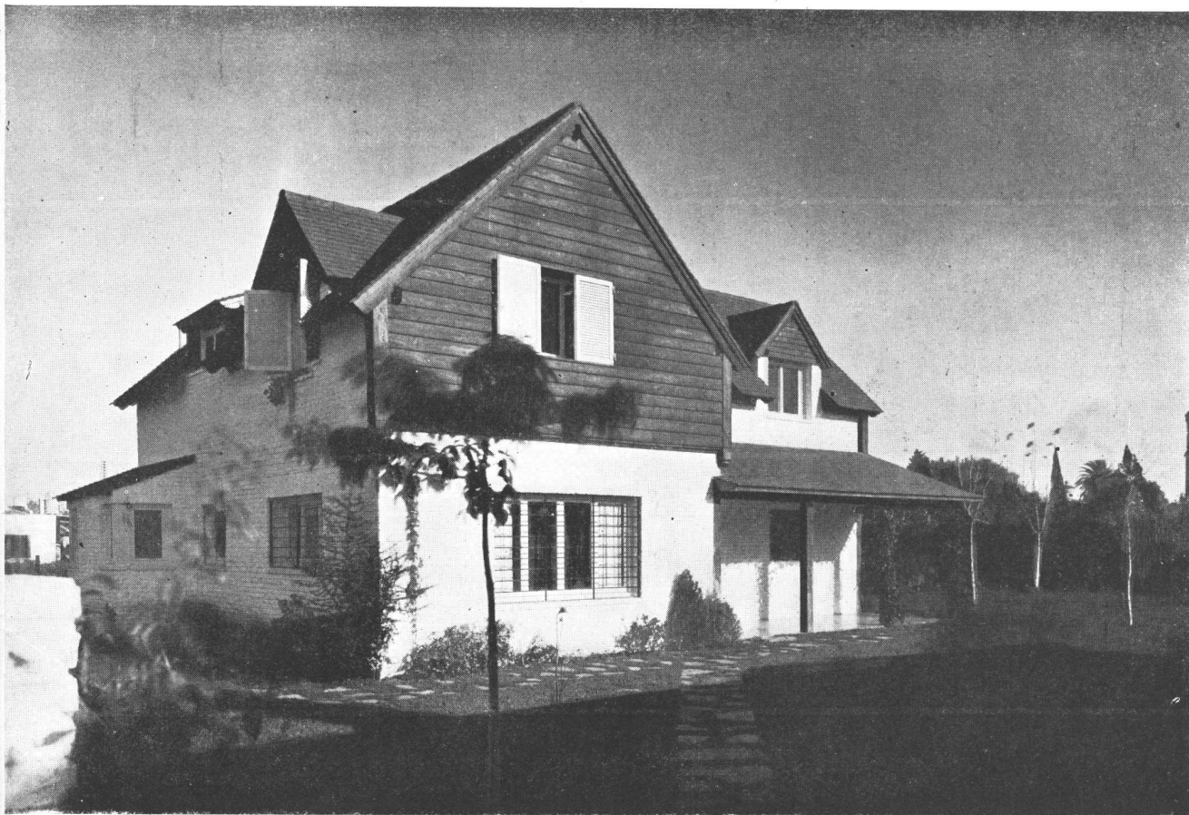
La fachada Noreste de la casa, ubicada en la calle España 566.
