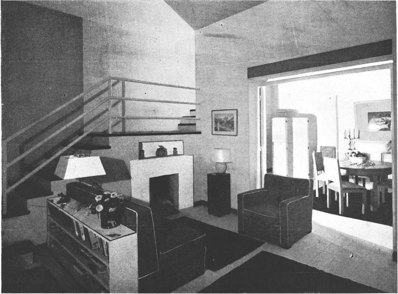
El living room. Escalera con escalones de madera dura y baranda de caños de acero al laqué blanco. Biblioteca contra el sofá de madera pintada de blanco al duco. Sobre la puerta de comunicación con el comedor, un panel de vidrio depulido proporciona la luz difusa.
