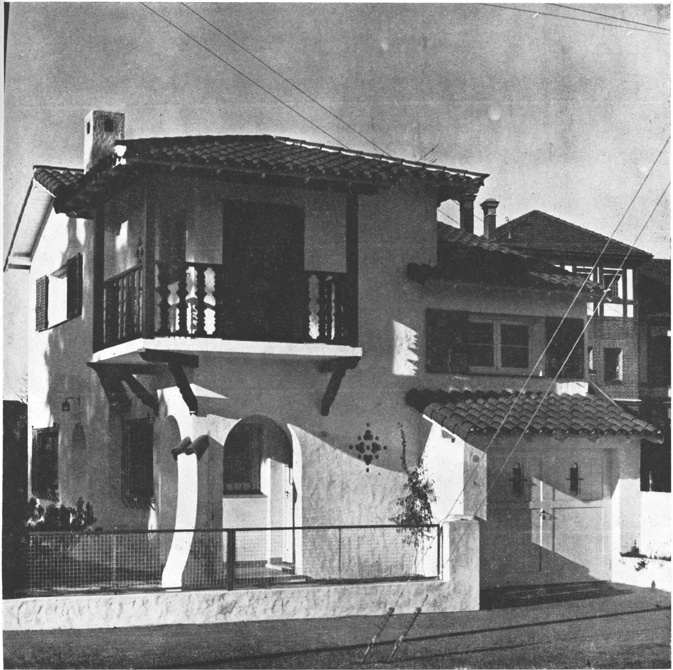
El frente de la casa, ubicada en la calle Alfaro 111. Las paredes son revocadas rústico y blanqueadas; las persianas se pintaron de color verde, las rejas de negro. El balcón es de madera de curupay barnizado color natural.
