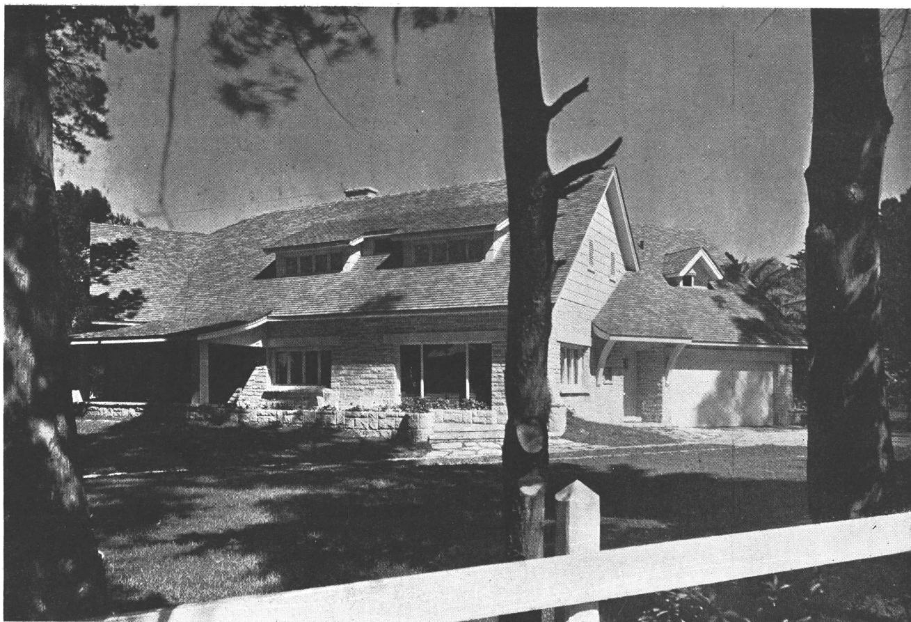
EL FRENTE realizado en piedra de Mar del Plata; techado de tejas planas "Llao Llao".
