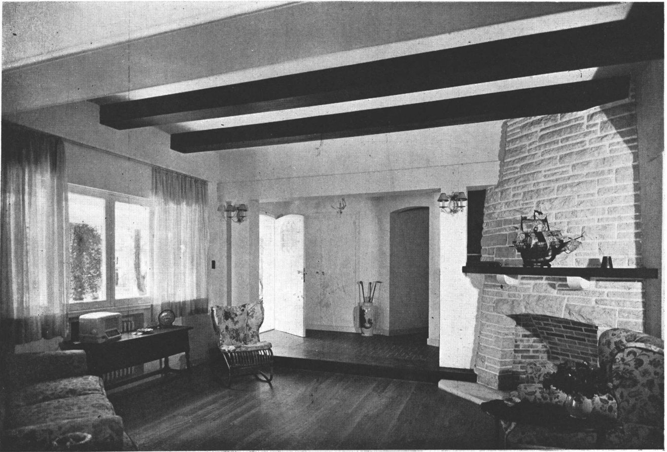
El rincón de la chimenea en el living room; paredes pintadas al agua en color blanco; puertas y ventanas pintadas al óleo blanco; chimenea en piedra con hogar en ladrillos.
