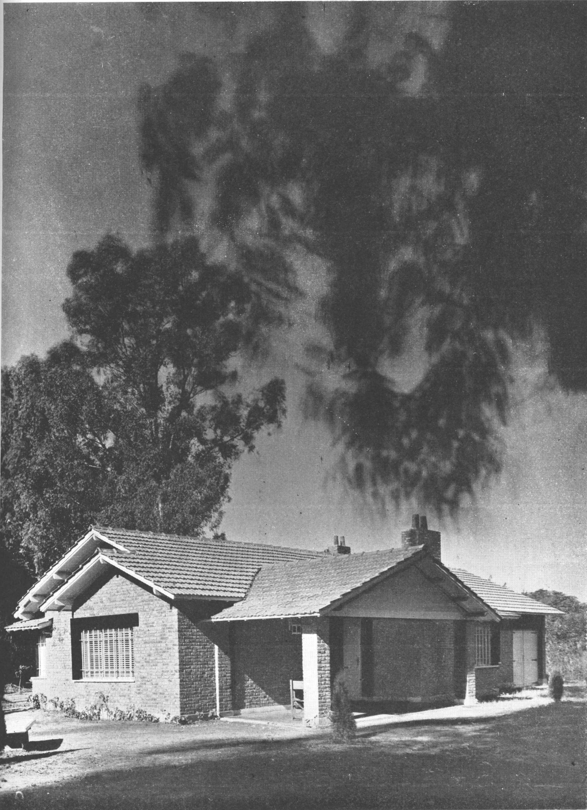
Perspectiva tomada desde el costado N. E. mostrando la pintoresca composición de las fachadas y movimiento de los techos. La mampostería a la vista ha sido ejecutada con ladrillos con juntas tomadas y combinada con revestimientos, dinteles y esquineros de madera dura hachuelada.
