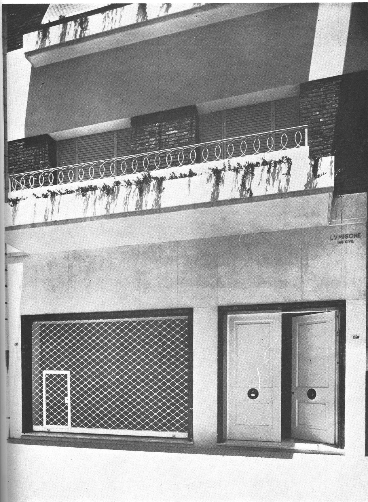
DETALLE DE LA FACHADA EN PLANTA BAJA. Revestimiento de mármol blanco de Carrara martelinado. Contramarcos de las aberturas principales, en mármol rojo moldurado. Puerta de calle terminada al duco blanco mate, con herrajes dorados.
