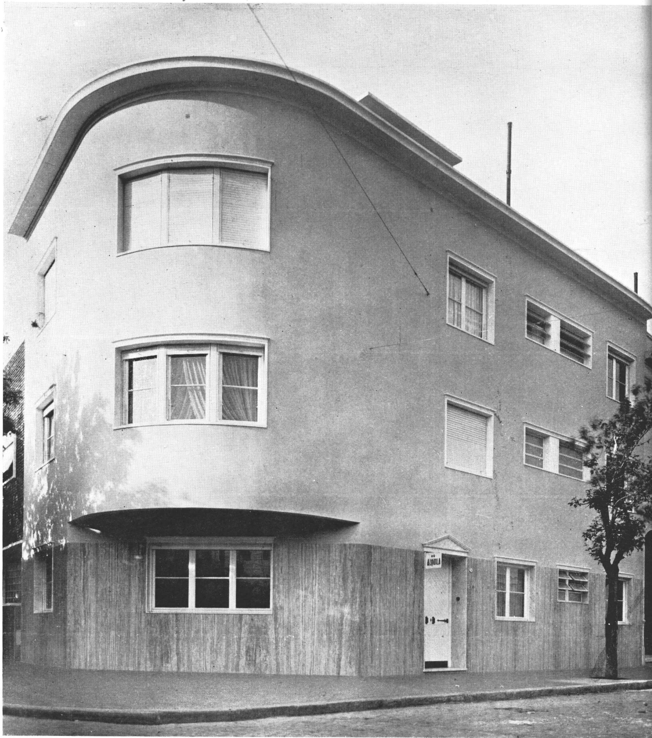
La fachada de la casa situada en la esquina de Deán Funes y Estados Unidos
