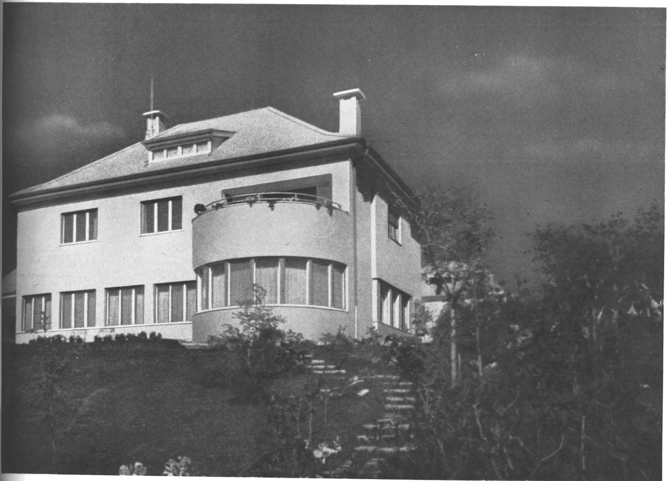
El contrafrente y parte de una de las fachadas laterales
