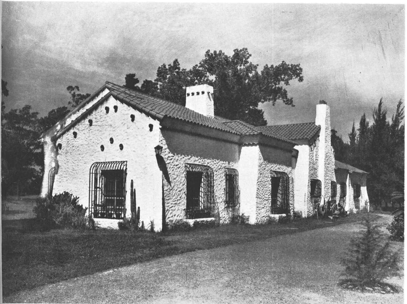
La fachada Sud Oeste
