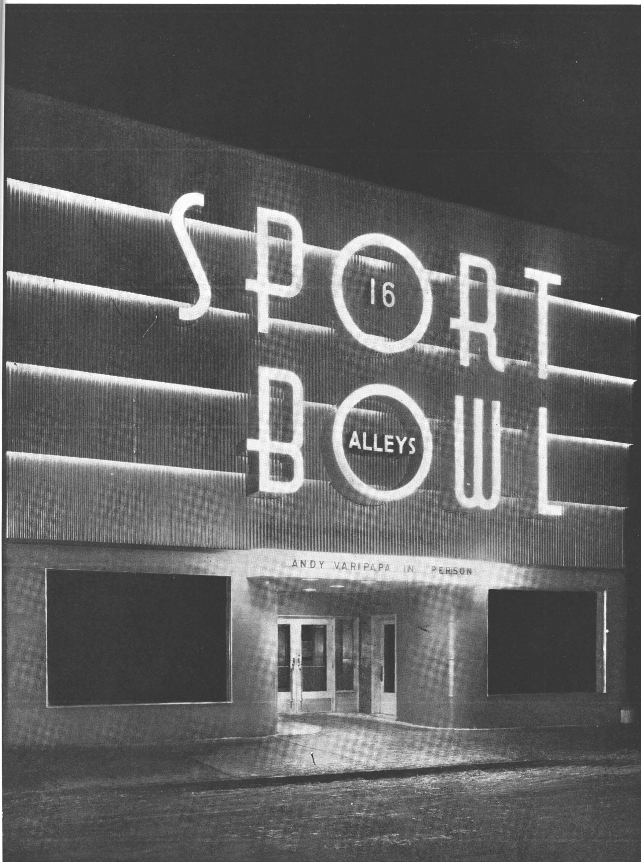
Vista nocturna de la fachada. El efecto ha sido asegurado, de manera económica, por el uso de chapas esmaltadas y chapas de hierro ondulado.
