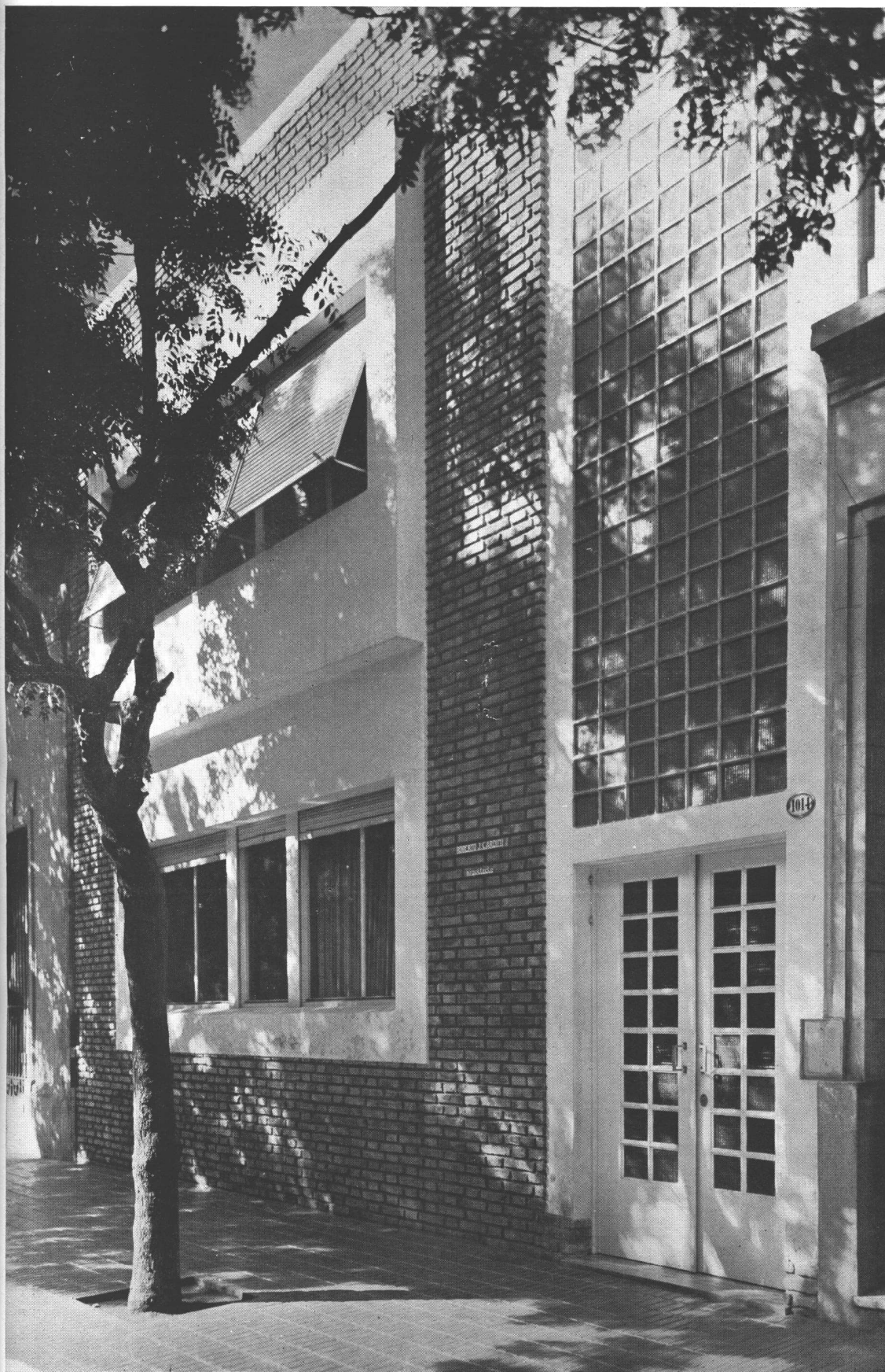
La fachada de la casa, situada en Pichincha 1014
