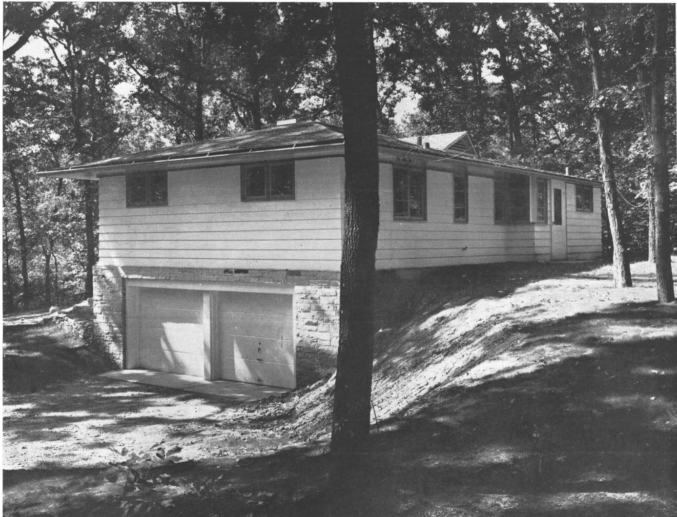
Vista exterior, del lado del garage
