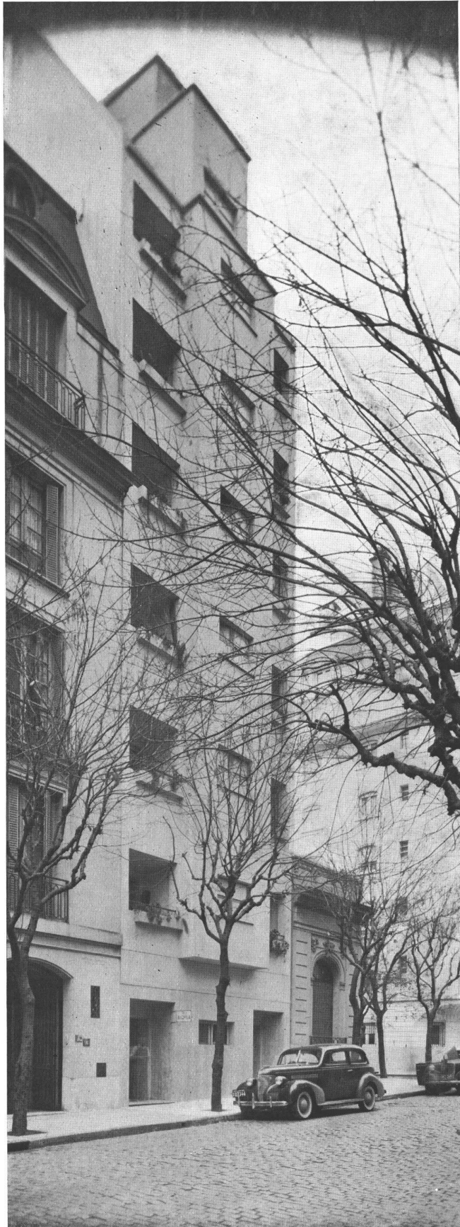
Fachada de la casa, situada en Arenales 2111
