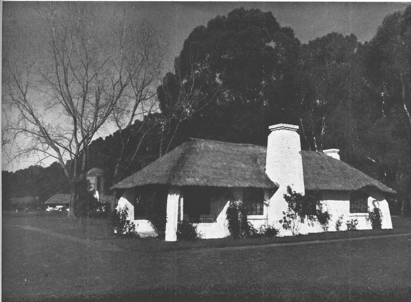
Casa N° 2. Propiedad del Arq. Dudley, y levantada como complemento de lo N° 1 (como casa de huéspedes para los amigos), en un lugar muy próximo a la primera.
