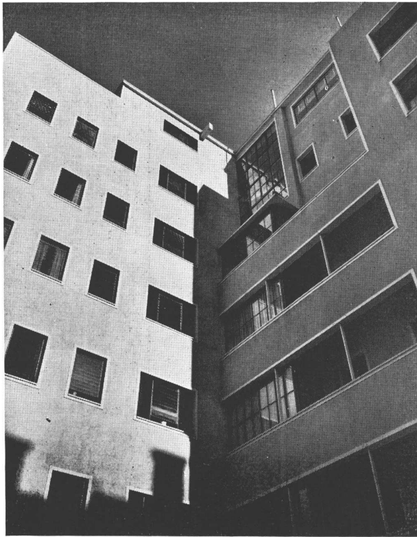
Detalle del contrafrente
