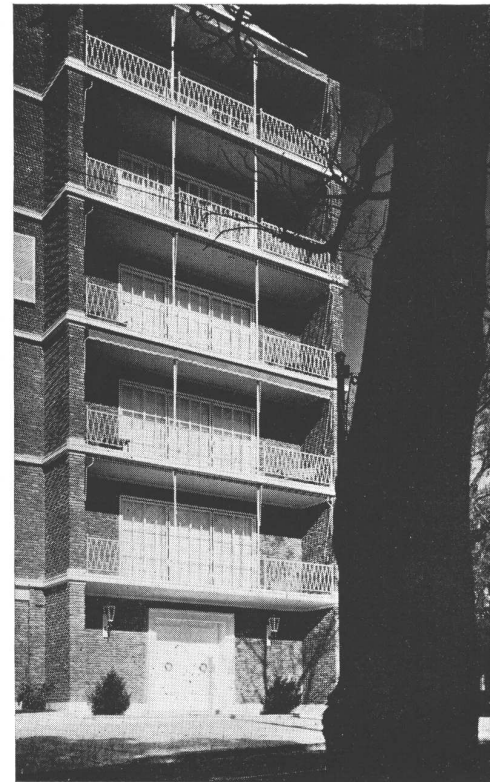
Detalle de balcones
