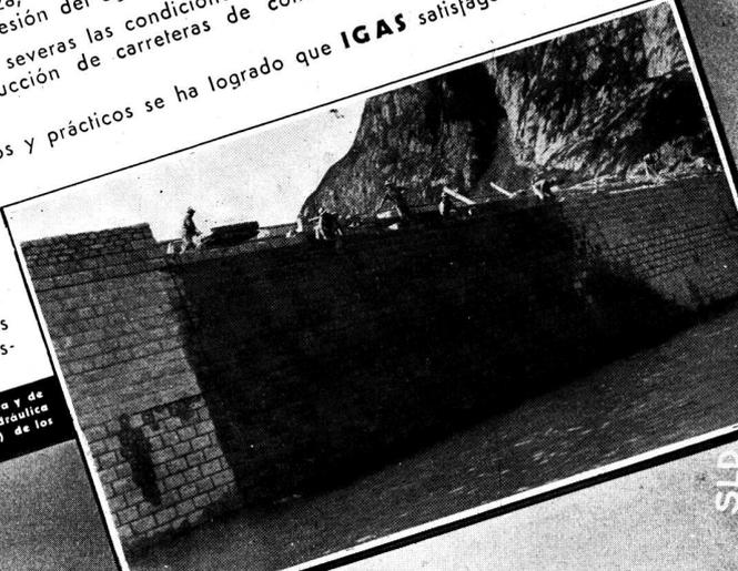
Reellenamiento con masa IGAS de las juntas de piedra y de dilatación en el muro de contención de la usina hidráulica de Barbazaine (1.889 metros sobre el nivel del mar) de los FF. CC. Federales Suizas.
