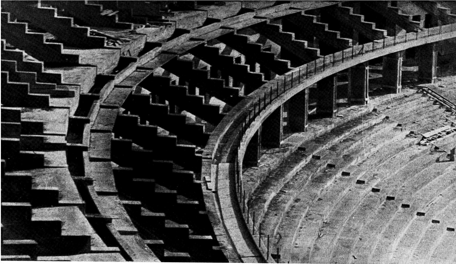
ESQUELETO EN HORMIGÓN ARMADO DE LAS GRADAS DEL ESTADIO OLIMPICO
