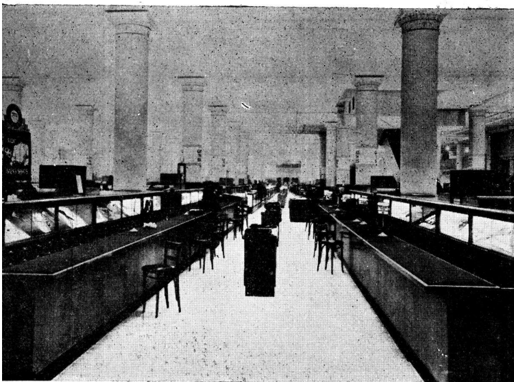
Figura N° 15. Alumbrado en base de reflectores disimulados, en las cajas sobre los escaparates
