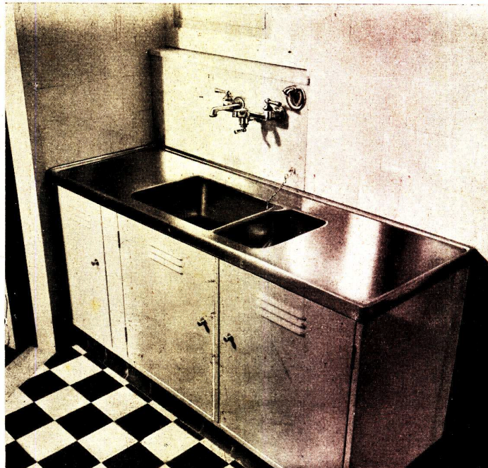
Obra Santa Fé 914; Ing. Walter Moll Piletas de ACERO INOXIDABLE
