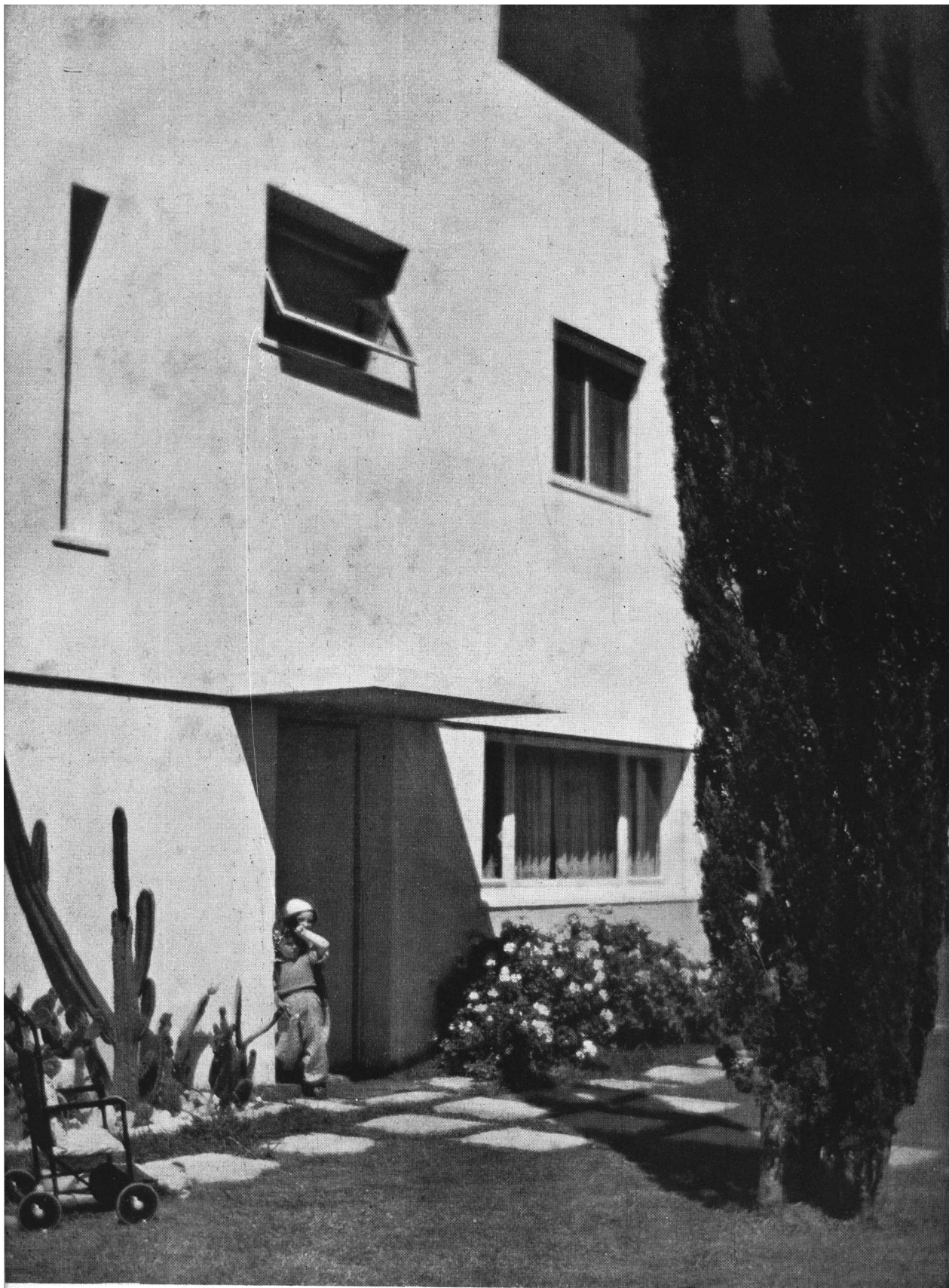
Detalle de la entrada
