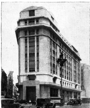
EDIFICIO «VOLTA» Por A. Bustillo 10 Baños de color
