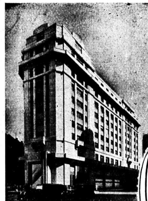
Edificio VOLTA Avda. R. S. Peña y Esmeralda
