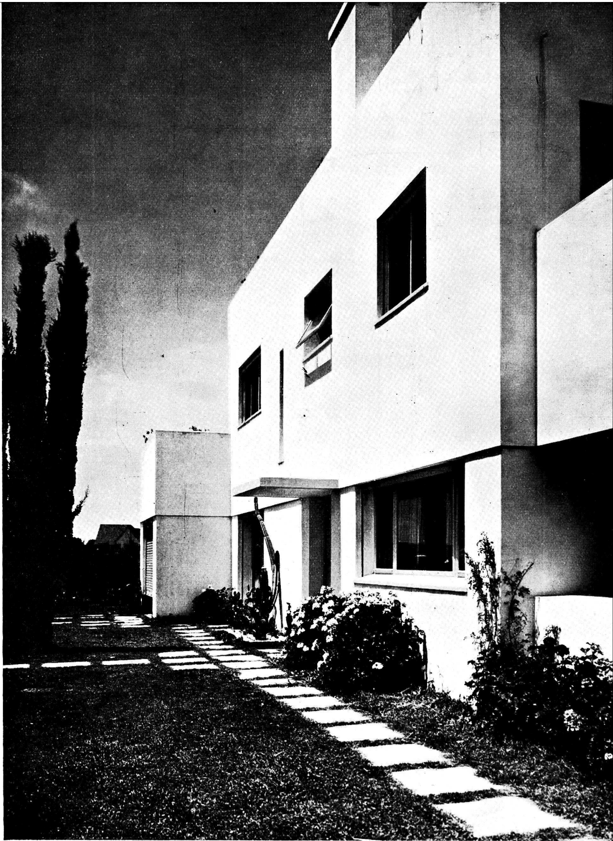
Detalle de fachada
