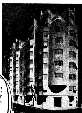
Edificio de Departamentos Avda. Alvear y Parera
