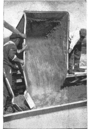
VIERNES HORMIGONANDO CON 'INCOR'
