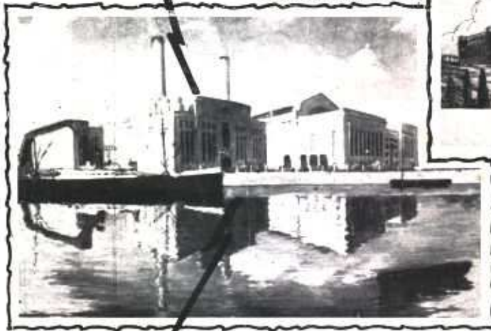
Super - Usina de la Cía. Hispano Americanana de Electricidad.
