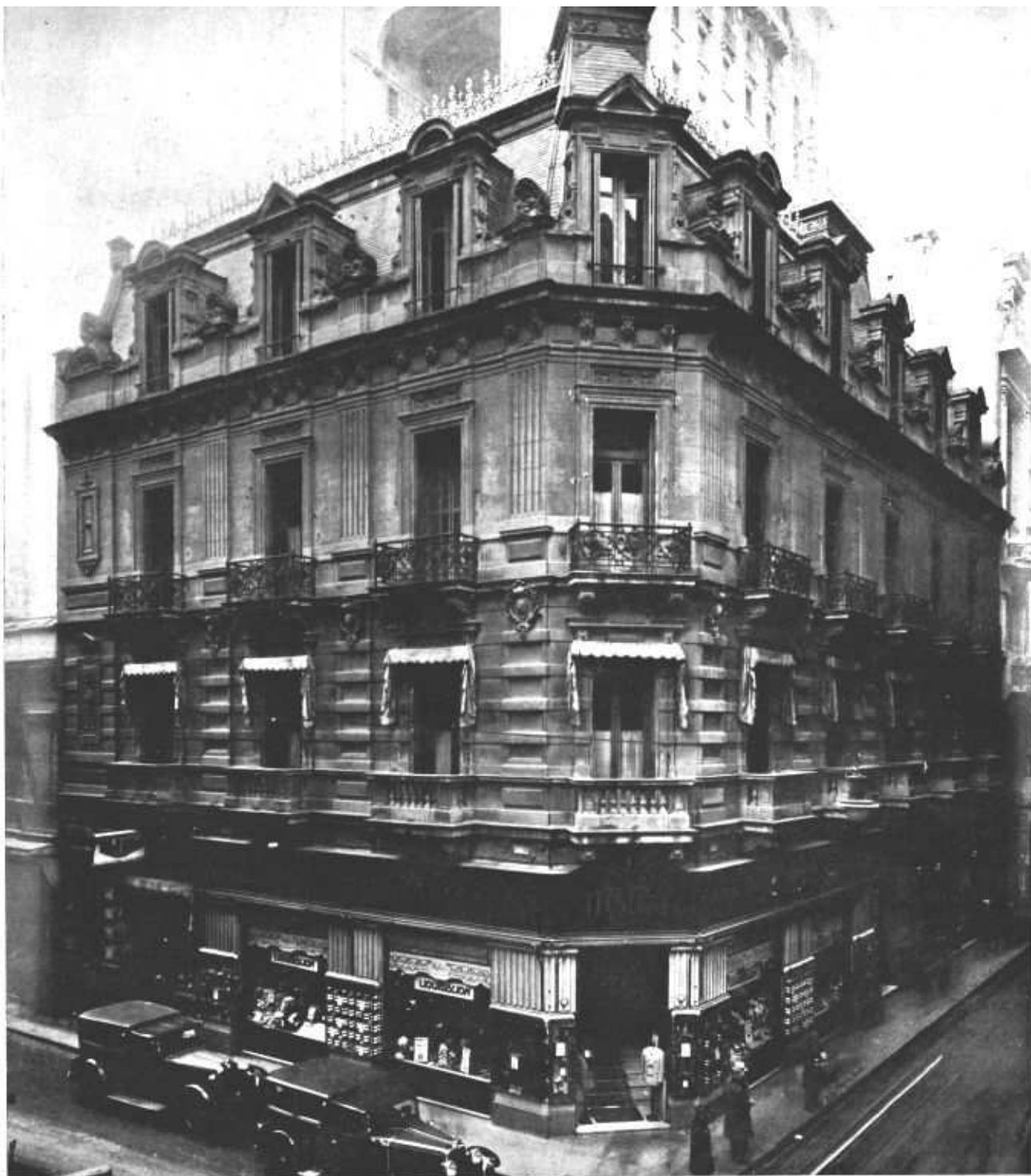
Vista del antiguo edificio
