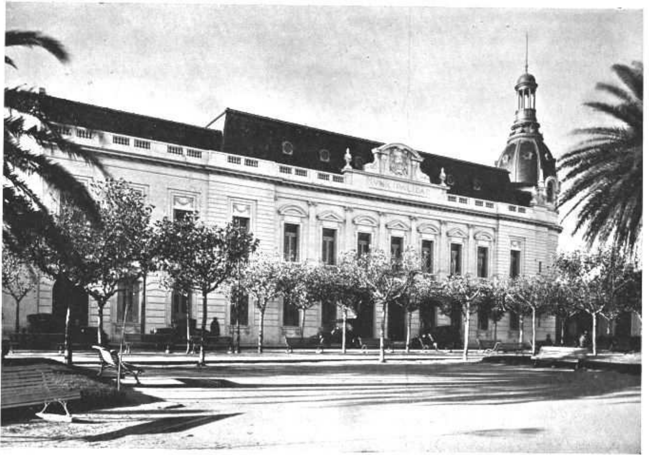
Fachada sobre la calle Florida
