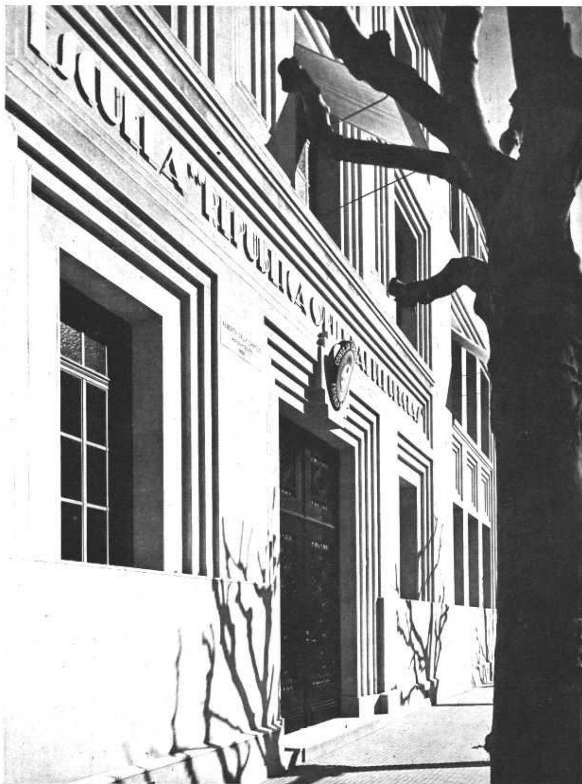
Detalle de la entrada
