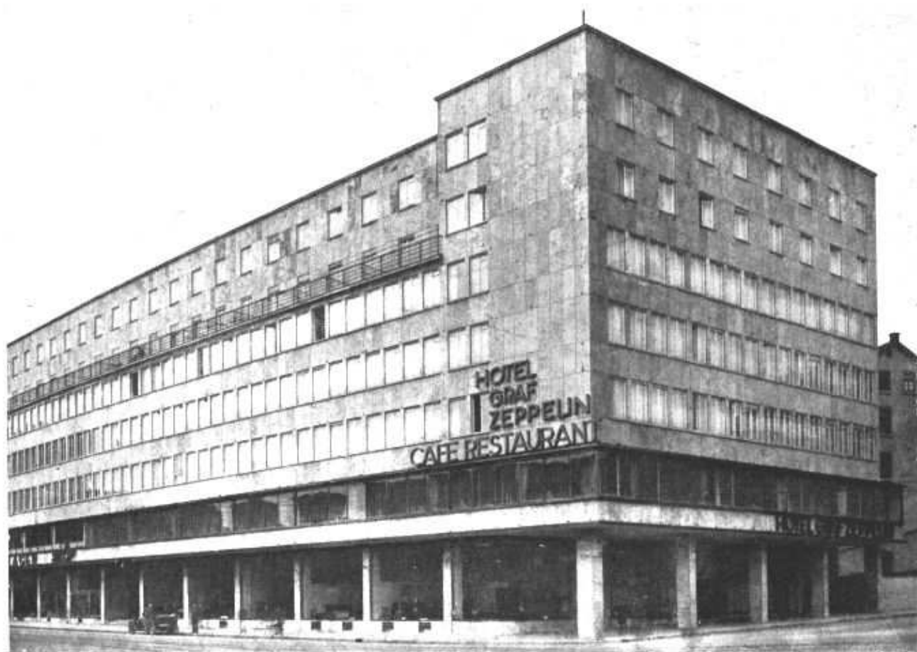
Vista de las fachadas - Revestimiento de mármol travertino
