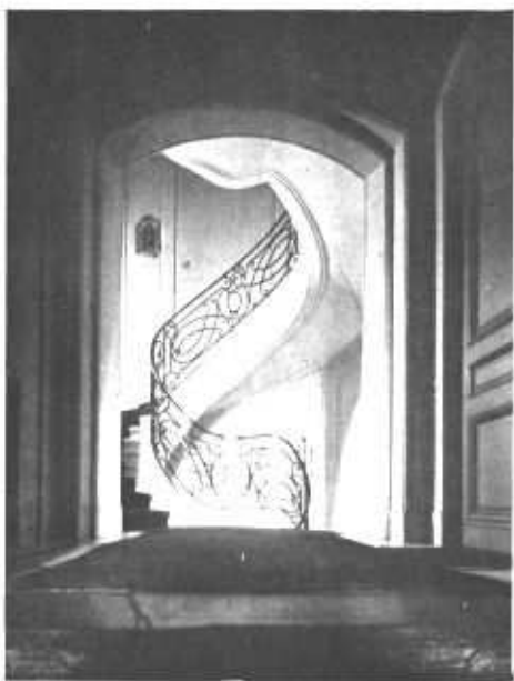
Detalle de la escalera
