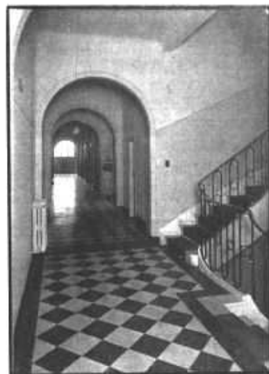
Vista del corredor a los departamentos de la planta baja
