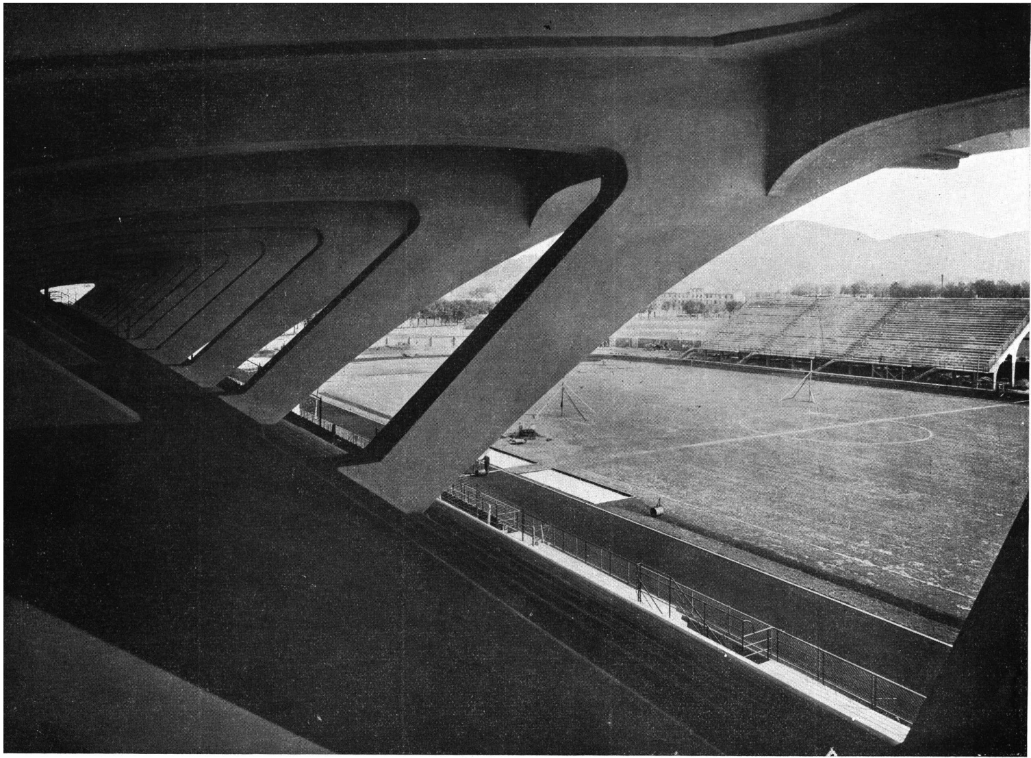
Detalle de las grandes ménsulas de la tribuna oficial
