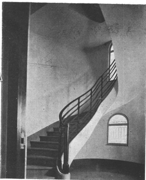
Arranque de la escalera principal
