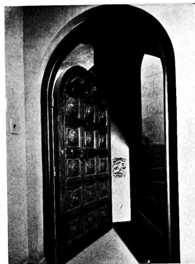
Segundo piso, puerta antigua y arranque de la escalera de caracol.
