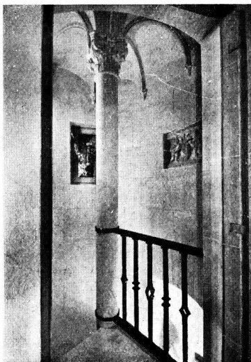
Llegada de la escalera de caracol Tercer piso
