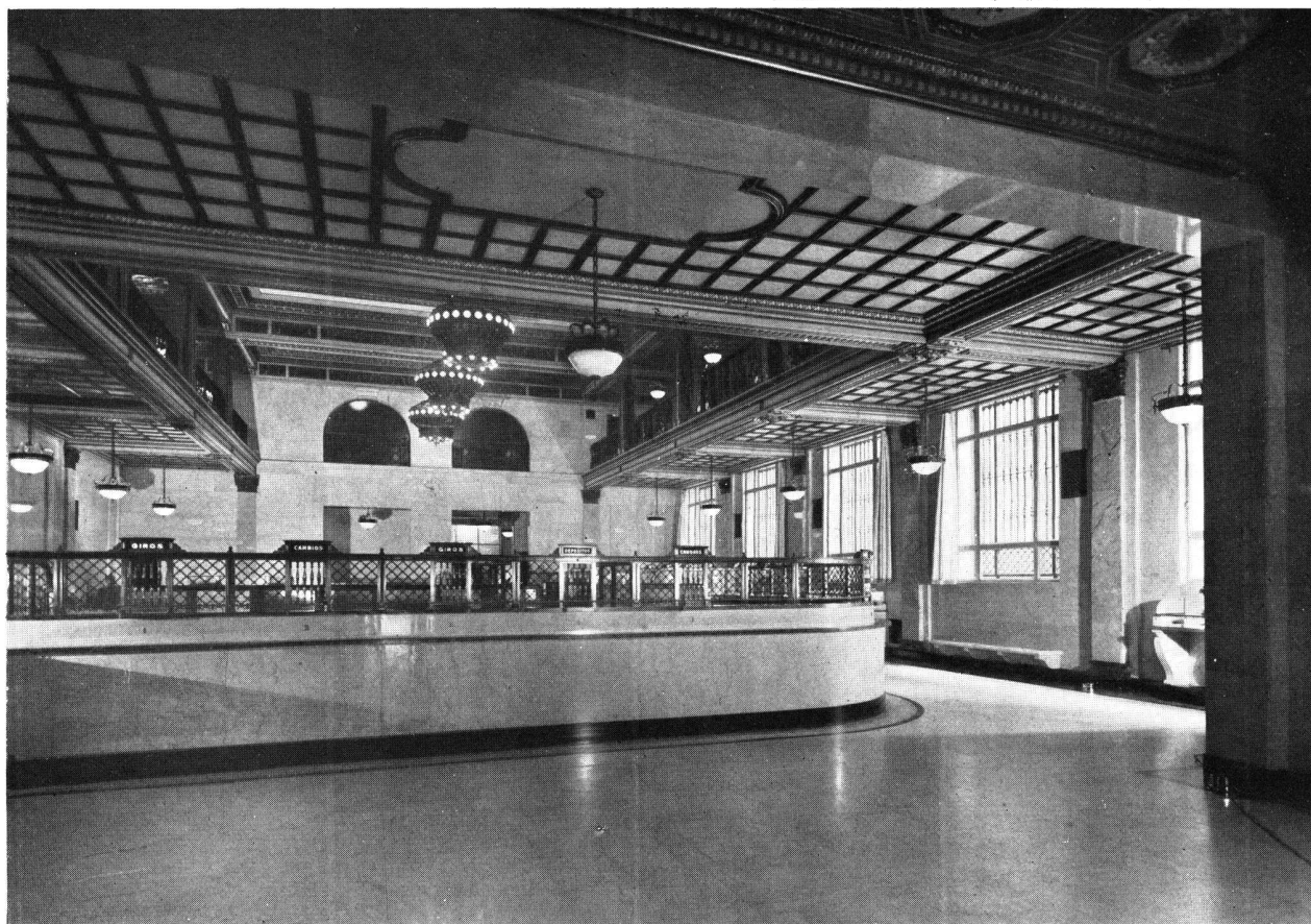
Vista general del Salón del Banco
