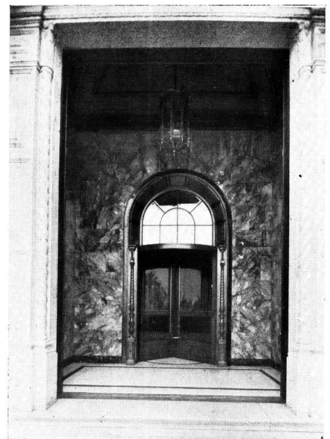
Puerta giratoria de la entrada principal
