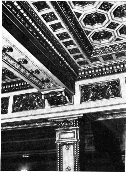
Vista del cielo-raso del gran salón del Banco
