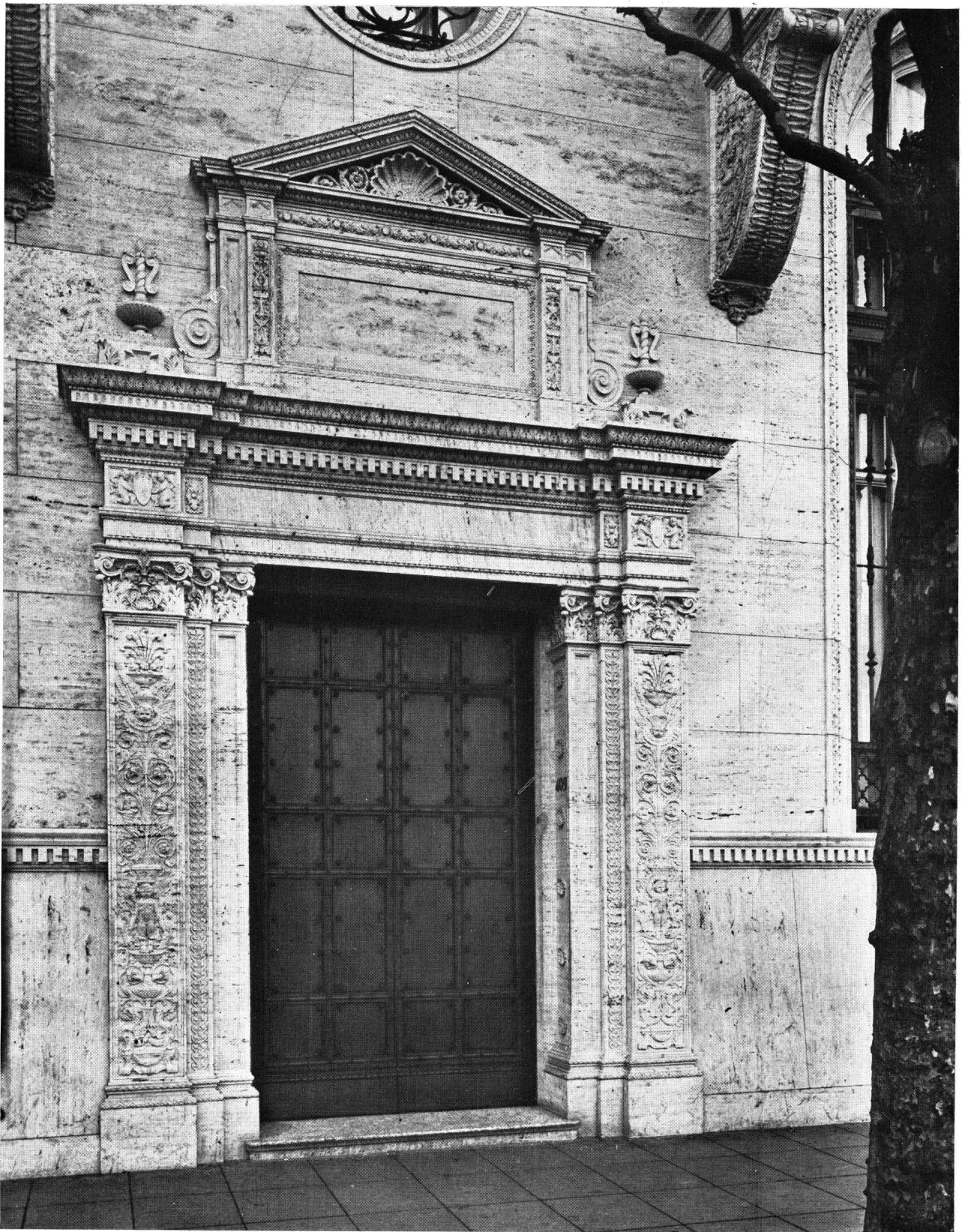
Edificio del Nuevo Banco Italiano Arquitectos: De Lorenzi, Otaola y Rocca (S. C. de A.)
