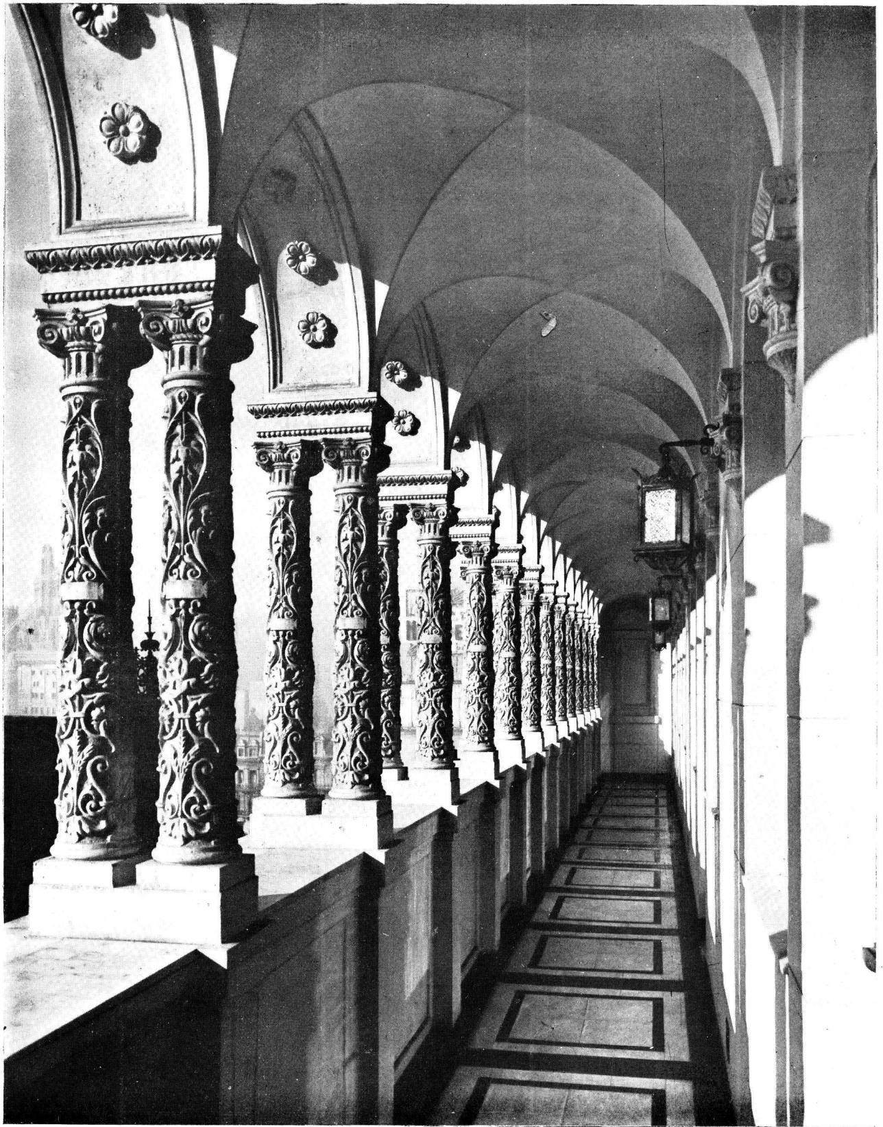
Edificio del Nuevo Banco Italiano Arquitectos: De Lorenzi, Otaola y Rocca (S. C. de A.)
