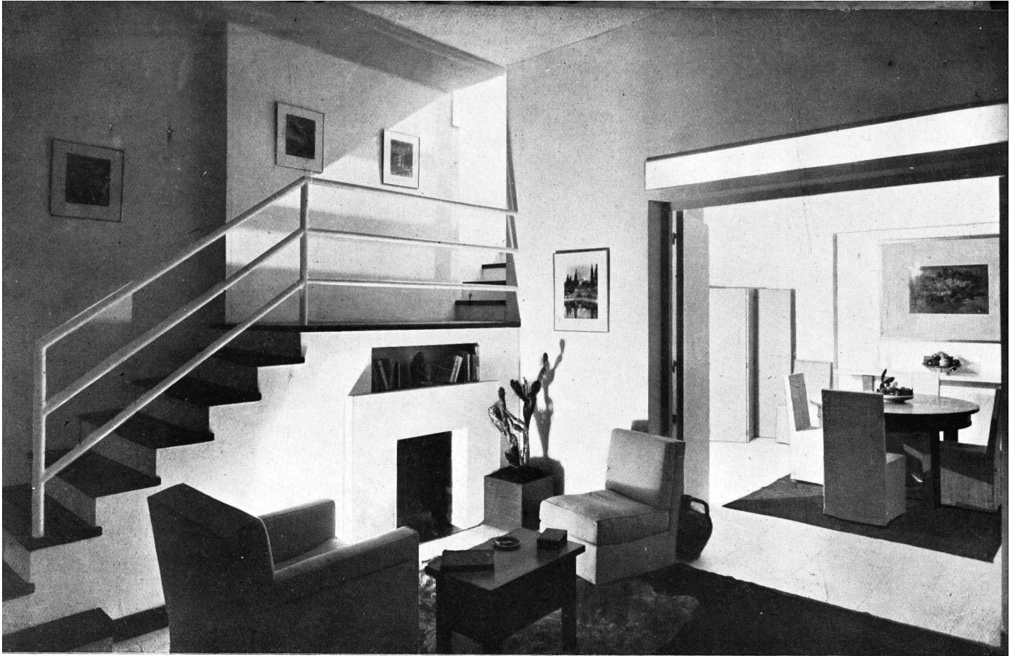
ARRANQUE DE LA ESCALERA Y DETALLE DEL HALL PRINCIPAL
