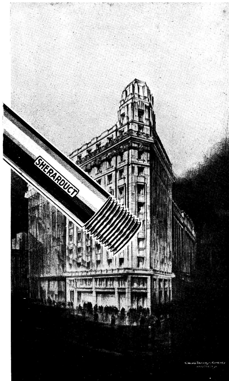
Edificio "MONTALEGRE S. A." Av. Pte. Roque Sáenz Peña esq. Esmeralda Arquitectos: Calvo, Jacobs y Giménez
