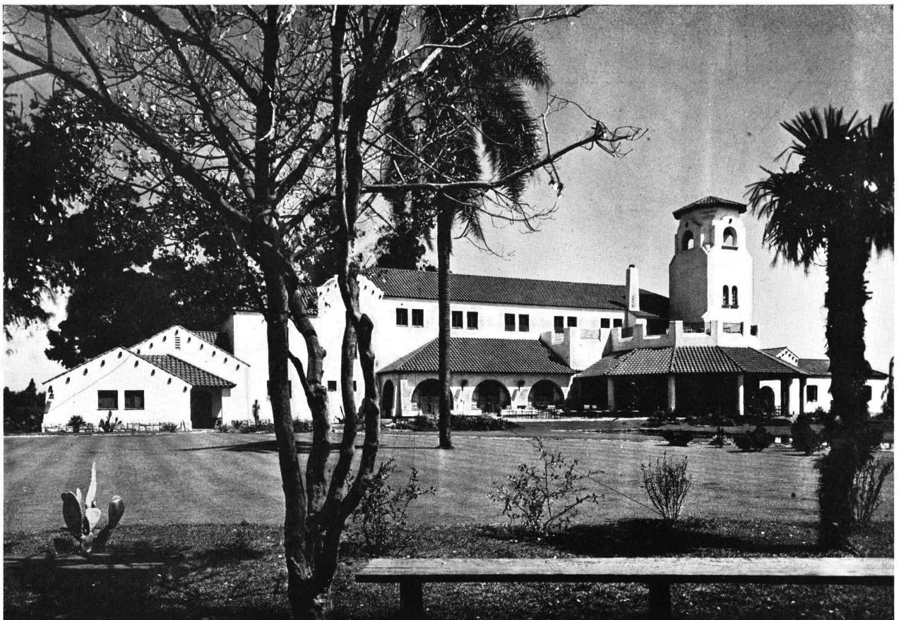
Edificio social visto desde la cancha
