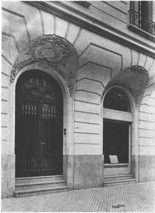
Vista de la entrada principal
