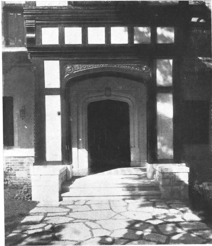
Detalle de la entrada
