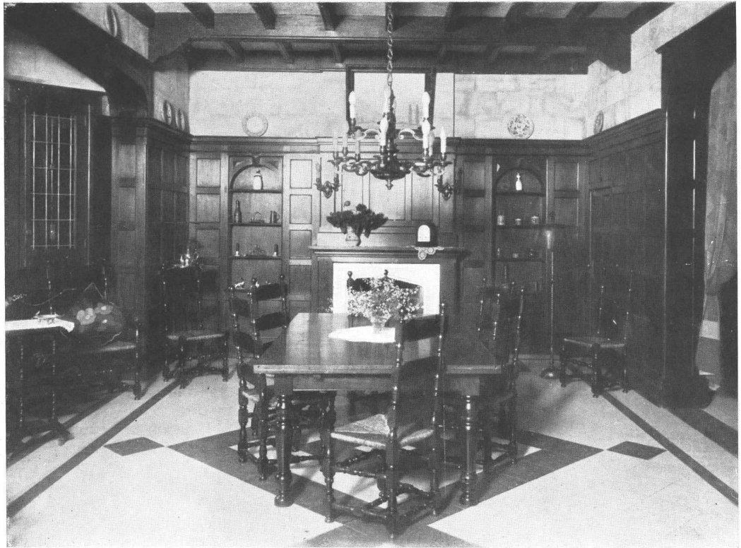
Vista del comedor
