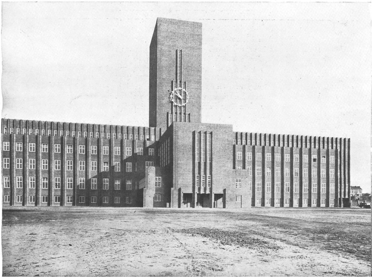
Casa Municipal de Rüstringen
