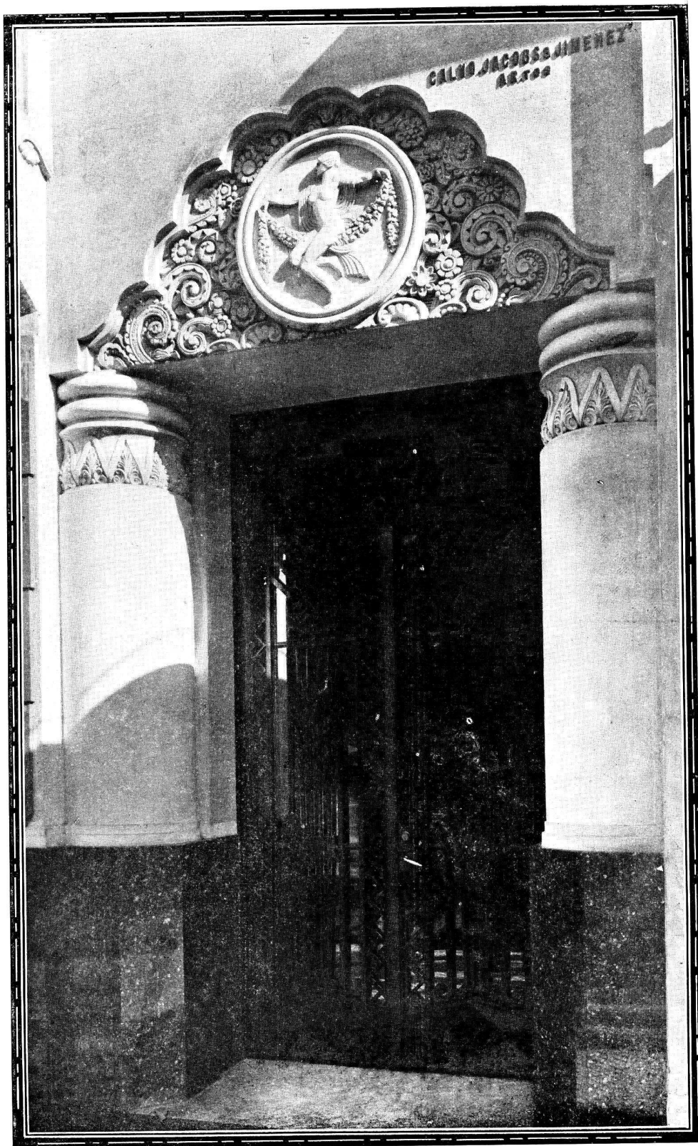
Detalle de una de las puertas de entrada a los Departamentos
