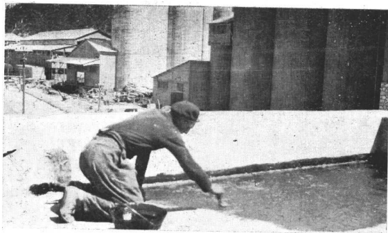
Silos de la fábrica cemento Minetti en Dumesnil Cubiertos con "DURSIT" - Empresa Constructora "GEOPE"
