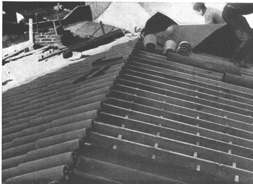
↓ Armazón tejereta tipo B con tablas de 1" x 6"
