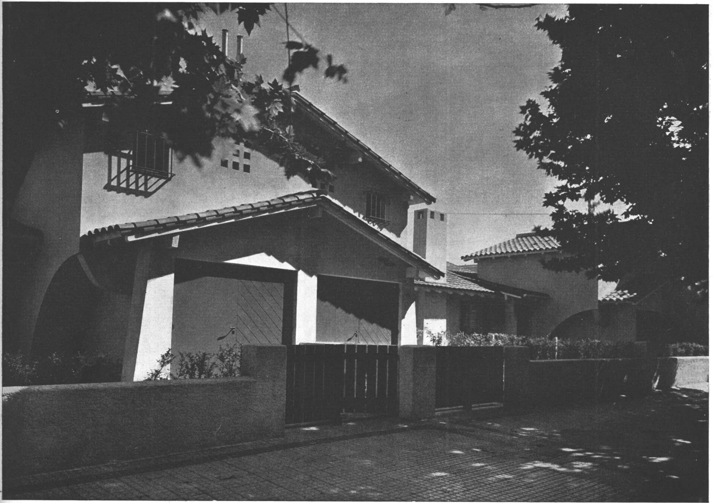
Detalle de fachadas
