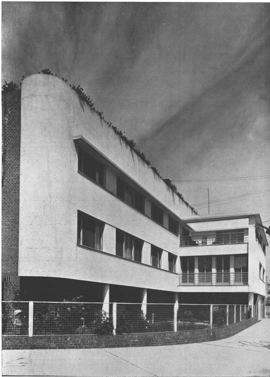
Perspectiva mostrando la solución de fachada y de planta sobre el vértice agudo del terreno
