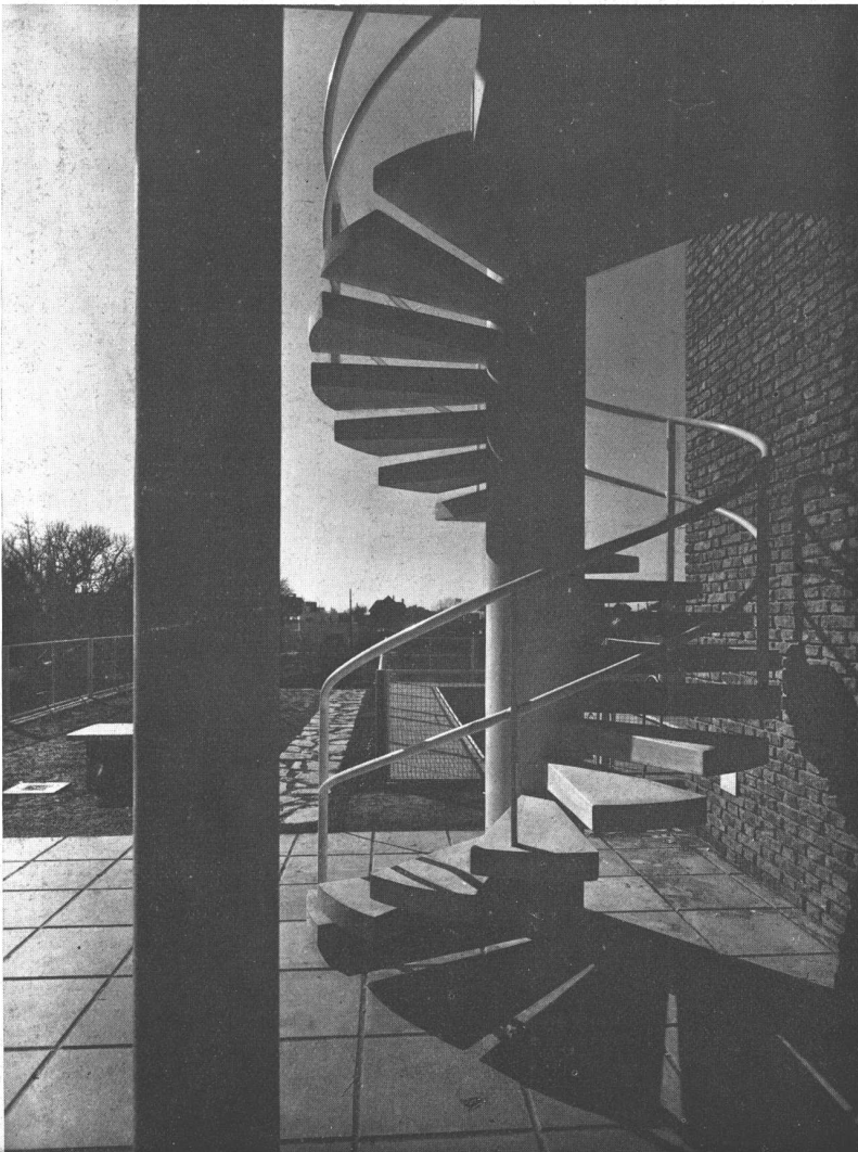
ARQ. CARLOS VILAR. Residencia particular en Vicente Lopez; vista de la escalera que une la planta baja con el sub-suelo al nivel del jardín y la pileta
