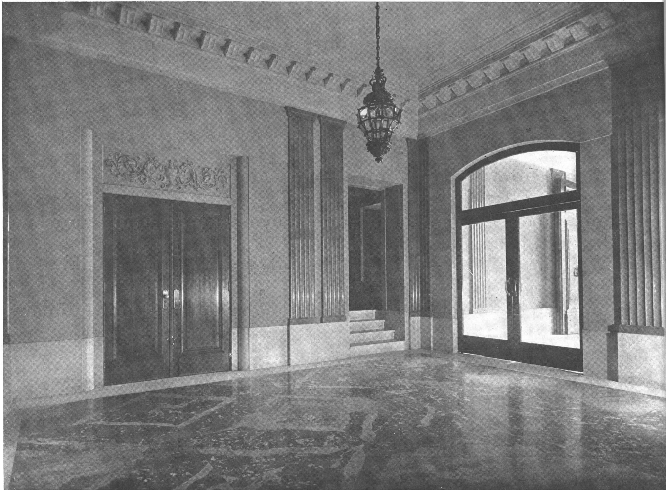
El hall de entrada; mármoles de Meruil, Encarnat. du Languedoc y Lunel Joinville; carpintería de roble, muros imitación piedra pulida.
