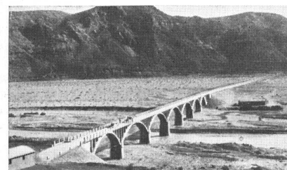
El sistema de arcos adoptados para los tramos centrales del puente, y el empleo total del 'INCOR', se debió al peligro que ofrecen los ríos cordilleranos, pues se producen corrientes ordinarias y extraordinarias en todas las épocas del año a causa de las lluvias en la parte alta de las montañas que derriban la nieve y arrastran sorpresivamente grandes caudales de agua. La alta resistencia inicial del hormigón elaborado con 'INCOR', constituye un importante factor de seguridad para la obra.
