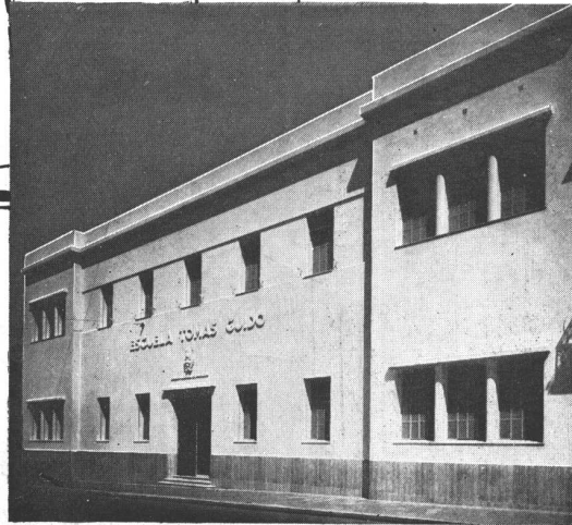
ESCUELA TOMAS GUIDO - SAN JOSE 1900 En esta obra se ha colocado techado asfáltico INTEC
