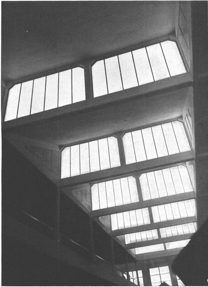
ING. ERNESTO J. PASMÁN. Edificio para una imprenta; dos vistas desde el interior. Se aprecia la ausencia de columnas y la iluminación perfectamente uniforme que se obtiene por la orientación, hacia el sud, de las superficies de vidrio de los "sheds".
