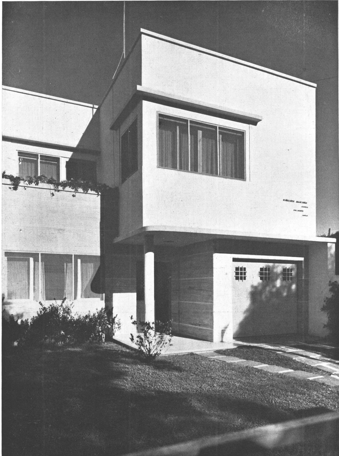
Detalle del porch de entrada y de la puerta del garage
