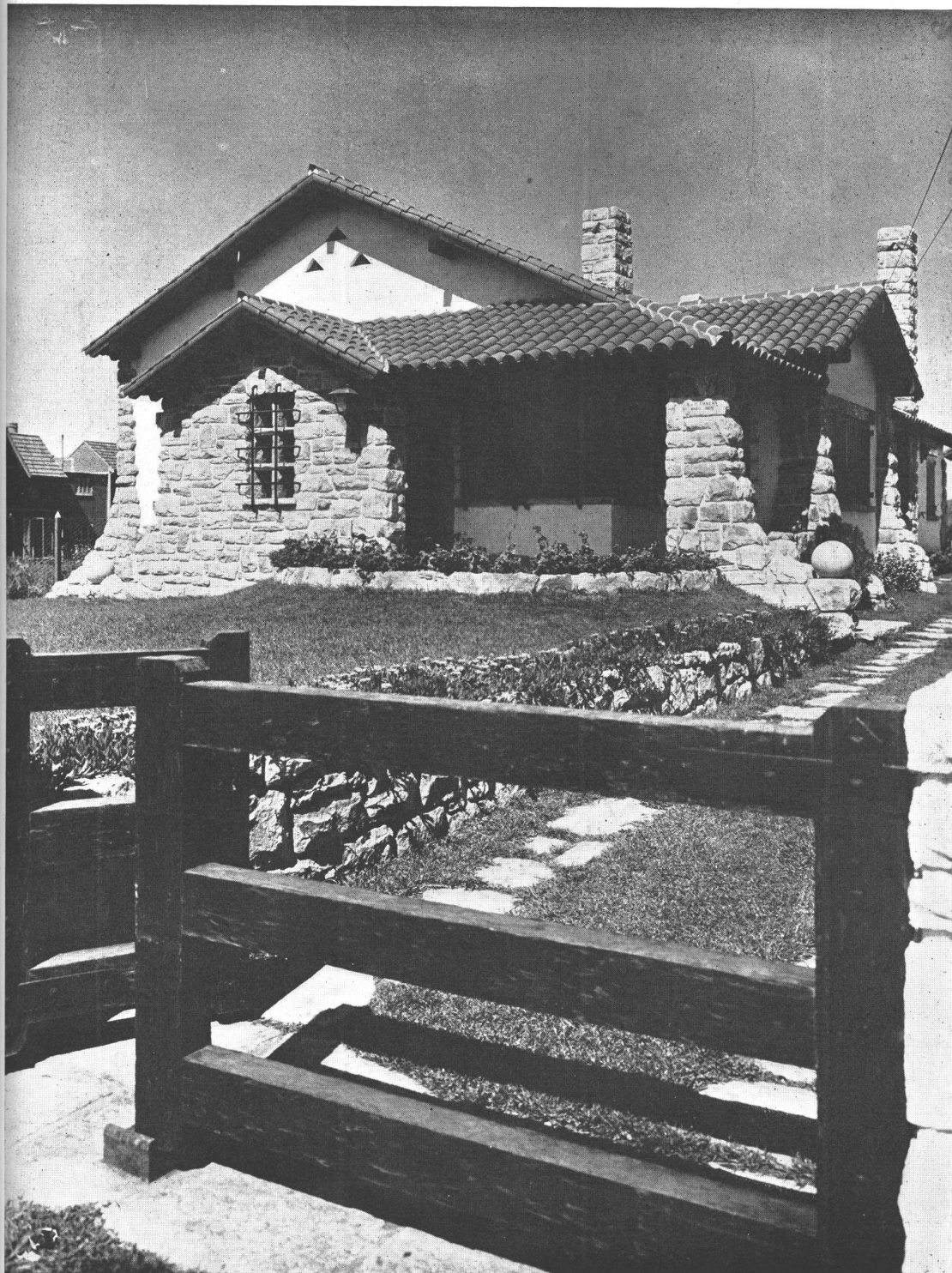
El chalet está ubicado en Punta Mogotes y es de propiedad del Sr. José A. Podestá. Frente al mar y lateral; vista desde la entrada
