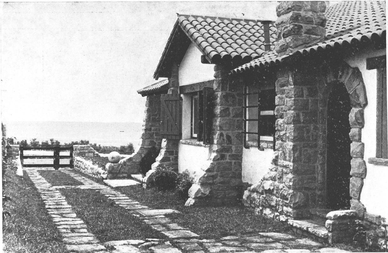
ARQ. E ING. CIVIL B. L. Y R. E. FON- TAN. Chalet en Mar del Plata; frente lateral N. O. y planta del edificio
