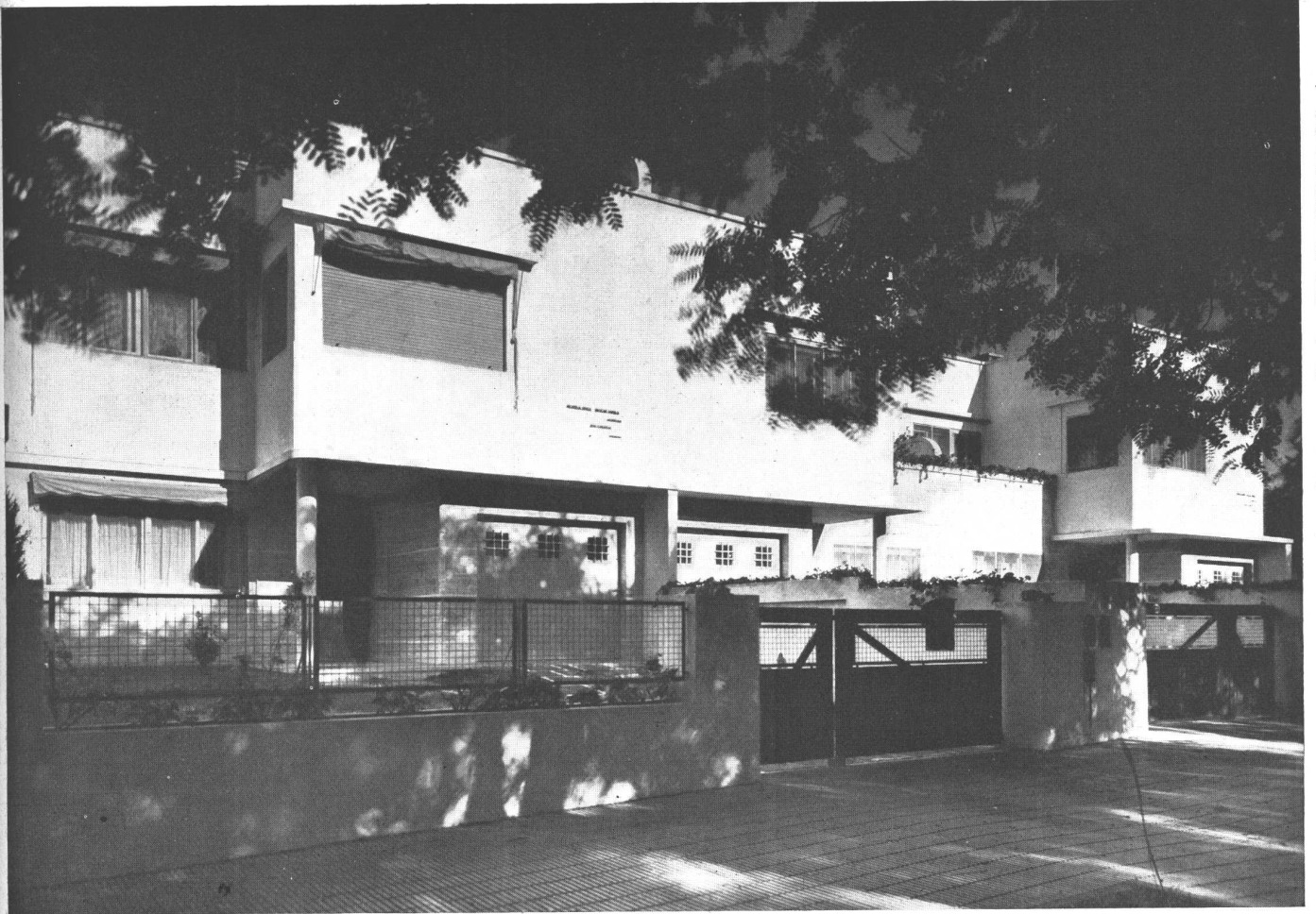
Vista de conjunto de las 3 casas
