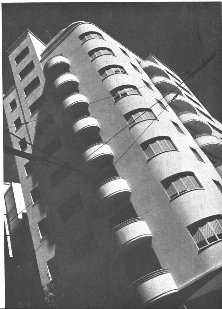
INGS. DE LA PUENTE Y BUSTAMANTE. Casa de Departamentos. Un detalle de la fachada
