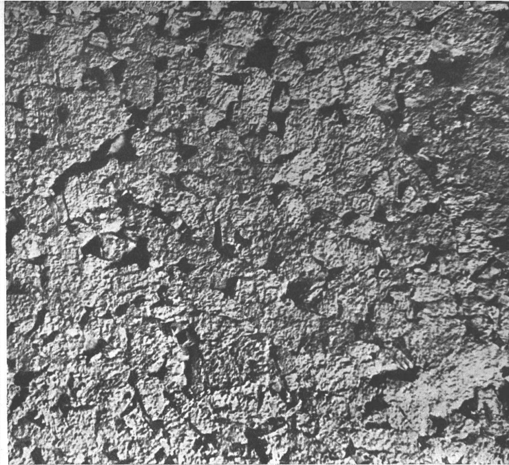
Corcho conglomerado. Aislante térmico en las bóvedas. Revestimiento acústico en el interior
