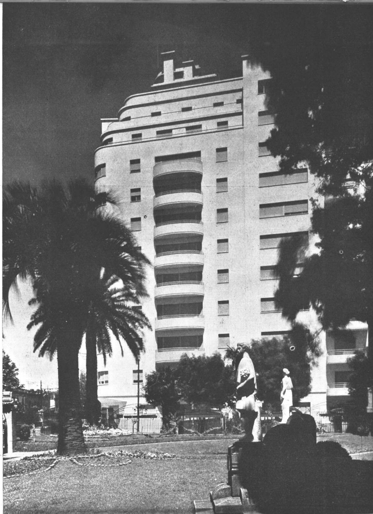
Fachada sobre la calle Añasco
