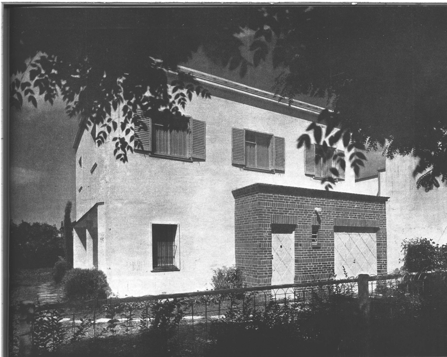
Frente de la vivienda sobre la calle Salta
