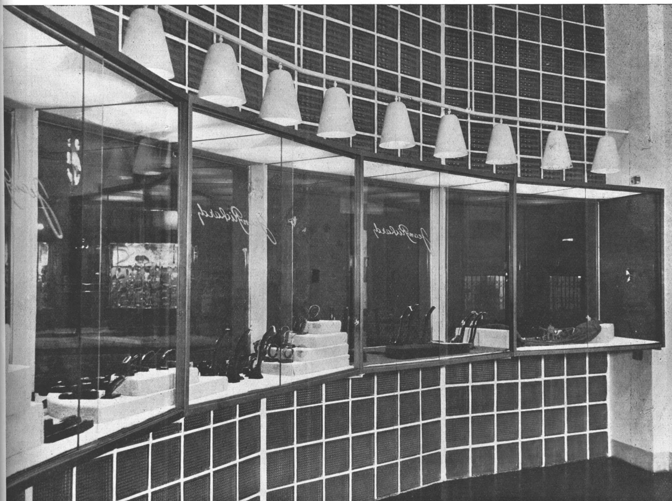
Fot. 2 — Las campanas reflectoras inciden sobre el vidrio opalino del techo de la vitrina, que deja pasar la luz en forma difusa
