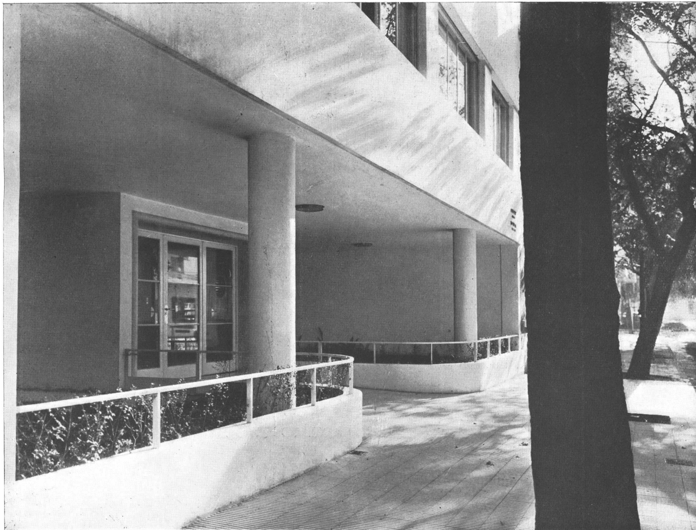
Una vista de la entrada de la casa situada en la calle Cnel. Díaz 2730
