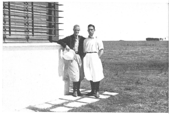
Lajas de piedra con juntas de césped alrededor de las casas. Nótese el campo aún desierto que se convertirá en el frondoso parque, según el plano de conjunto
