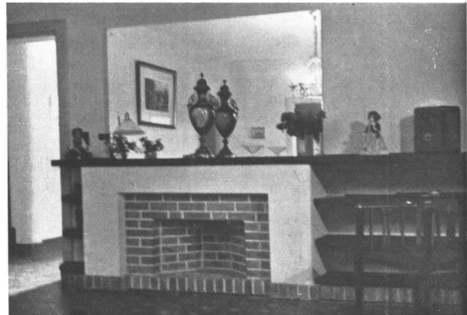
Chimenea en ladrillos refractarios y estanterías para libros en lapacho azuelado; zócalo de ladrillos refractarios; piso de cerámica y olambrillas heráldicas españolas
