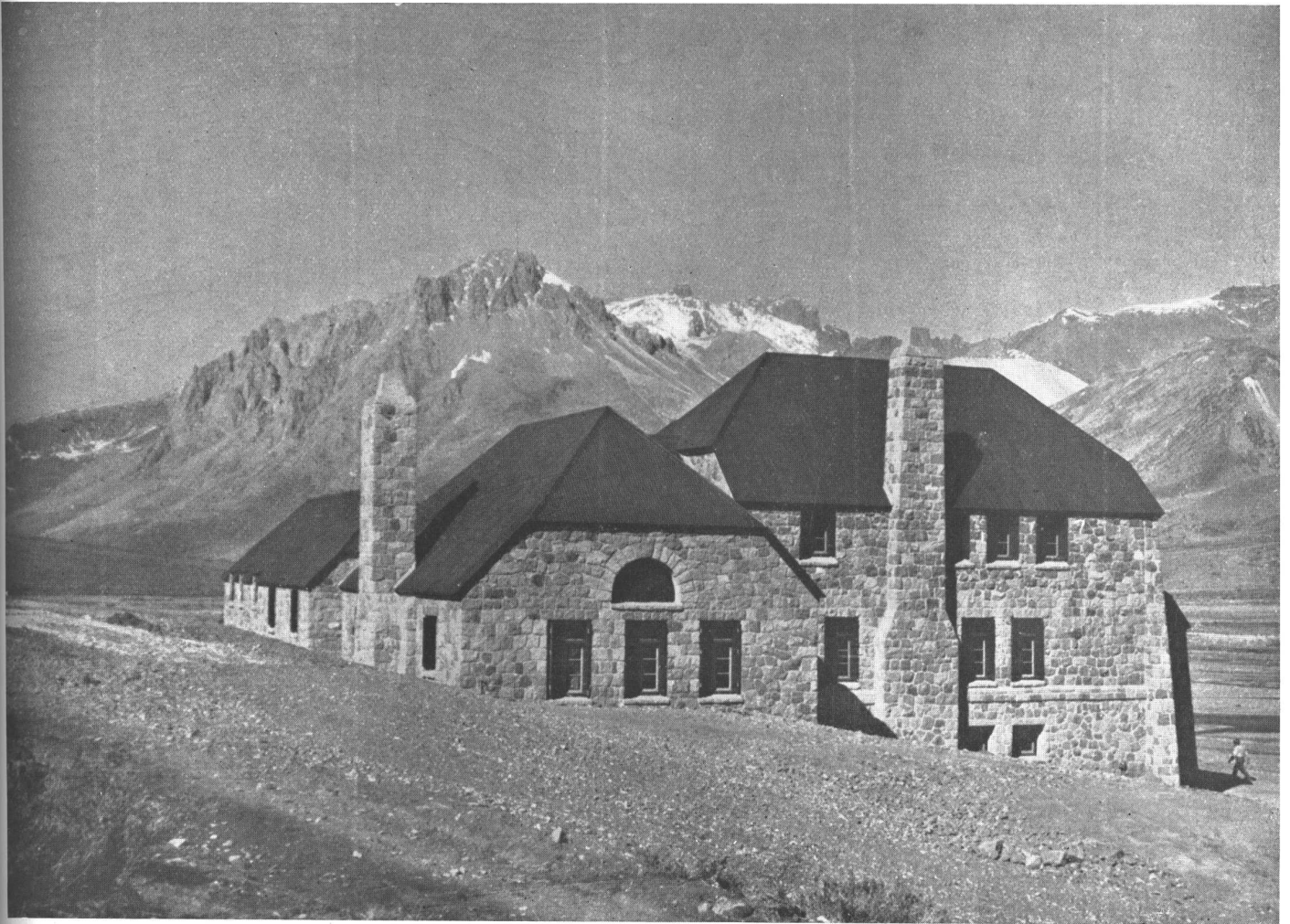
Fotografía de las fachadas lateral y posterior del hotel.
