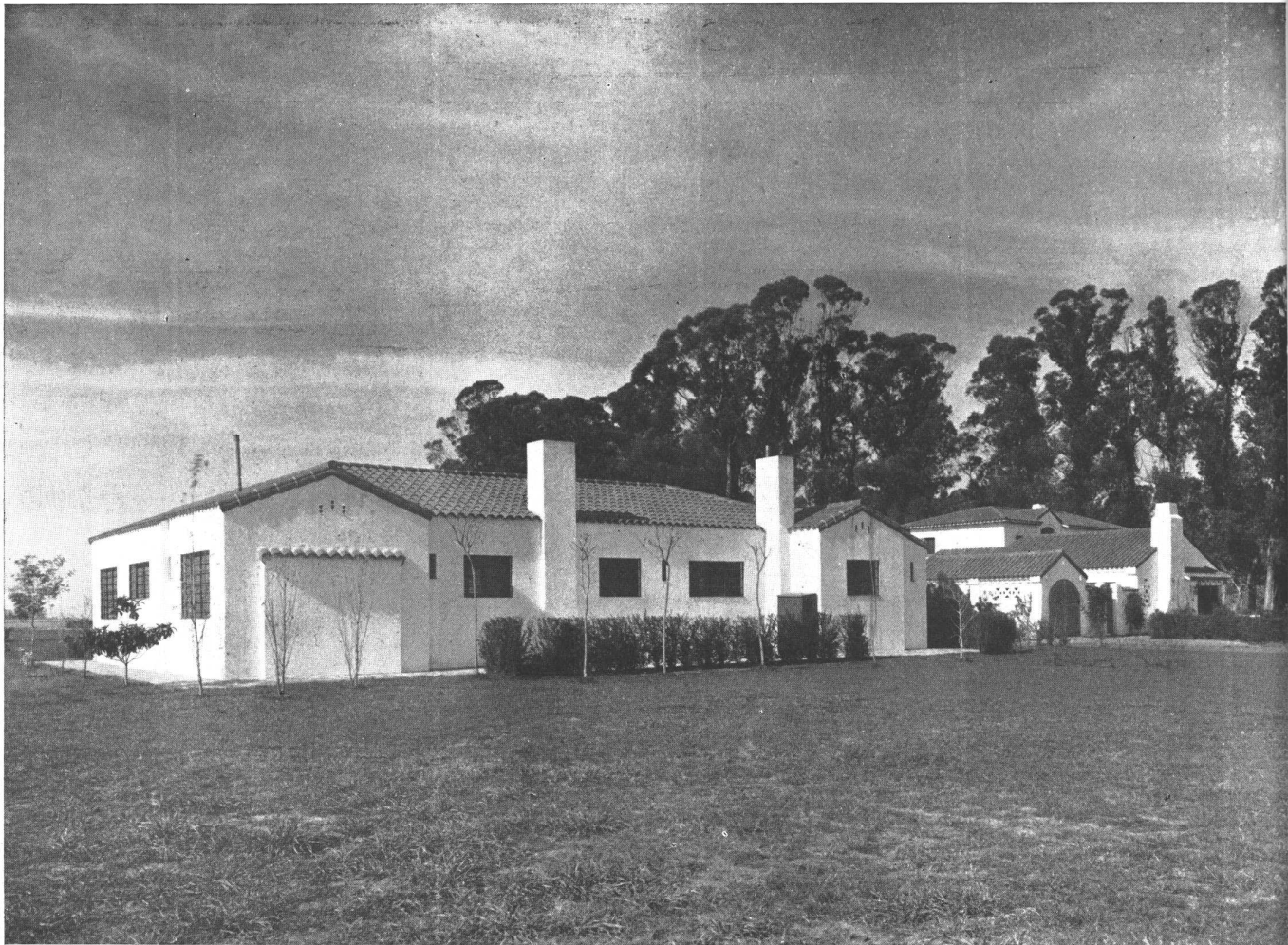
ING. LEON N. WEISSMANN. Casa de fin de semana en el Tortugas Country Club. Frente oeste. Al fondo el bosque de eucaliptus; todas las ventanas de este frente son chicas para aminorar los efectos del sol en verano
