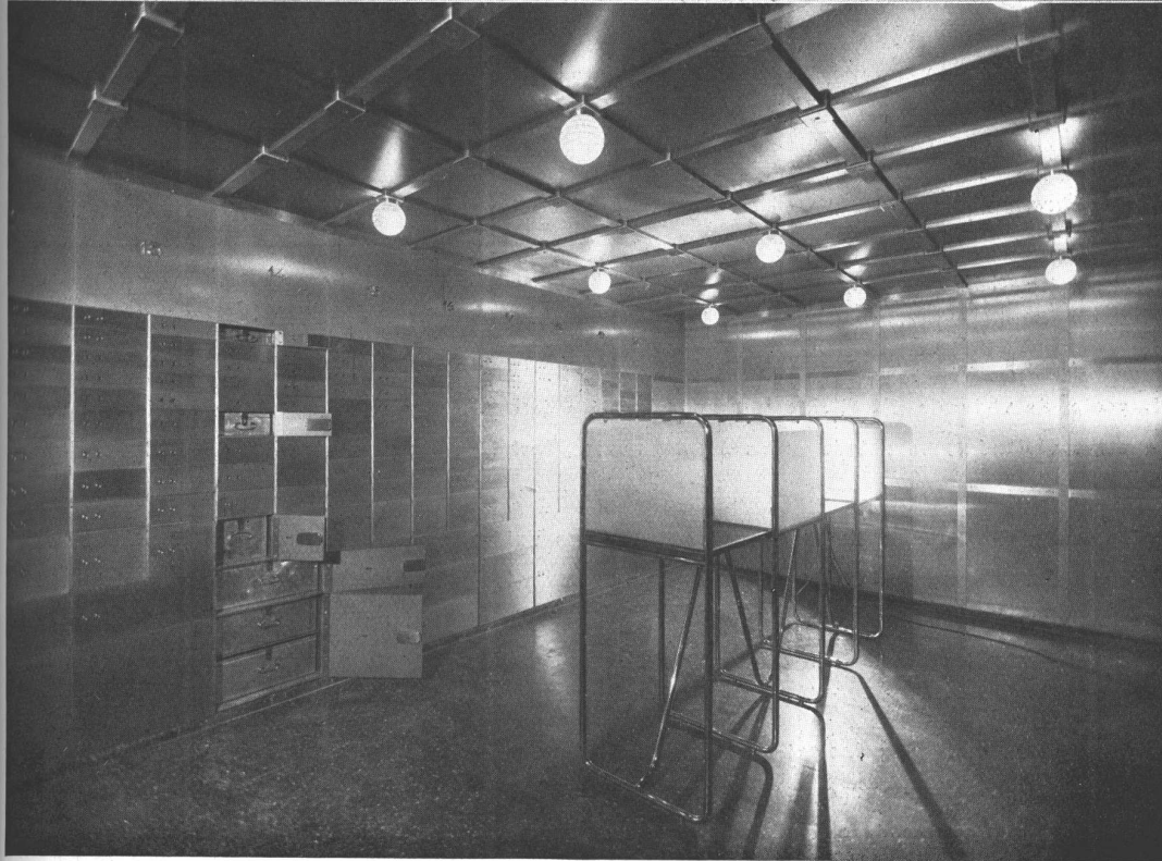
ANTONIO U. VILAR Y F. MEYER, INGS. Y ARQS. Nuevo edificio para el Banco Holandés Unido. ARRIBA, Hall de las Cajas de Seguridad; las rejas laterales comunican con las rondas de vigilancia que circundan el tesoro flotante. ABAJO, interior de las Cajas de Seguridad de acero níquel bruñido
