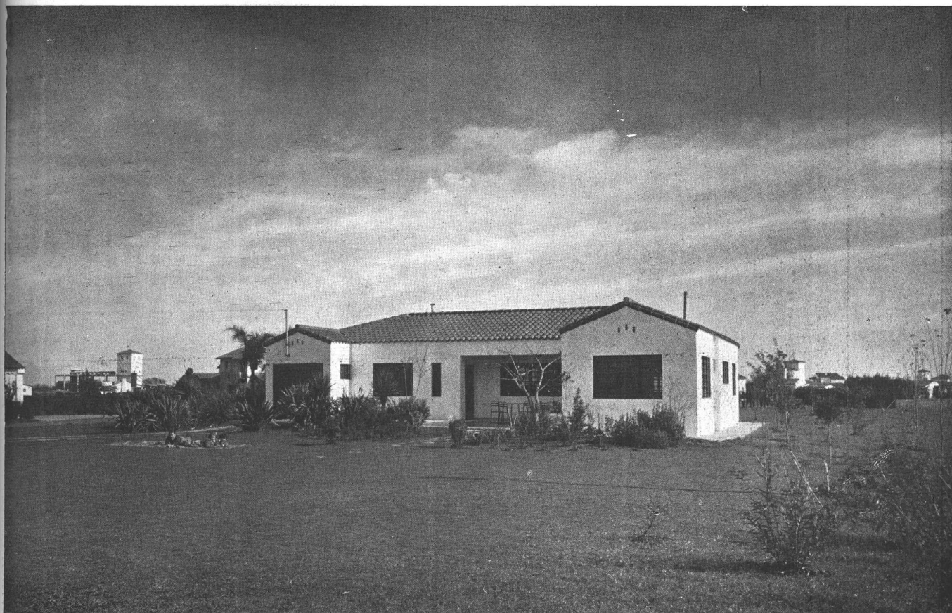
Otra vista del frente este
