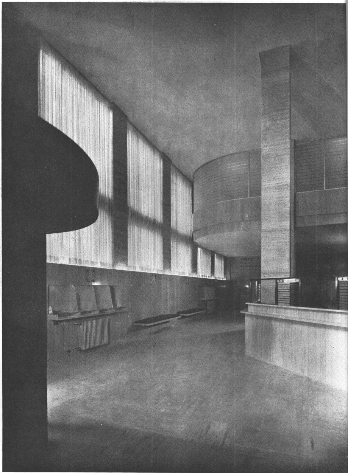
ANTONIO U. VILAR Y F. MEYER, INGS. Y ARQS. Nuevo edificio para el Banco Holandés Unido. Vista del espacio de público en planta baja sobre Bmé Mitre. En el fondo se ve la escalera de acceso a la sección extranjera en el 1º sótano
