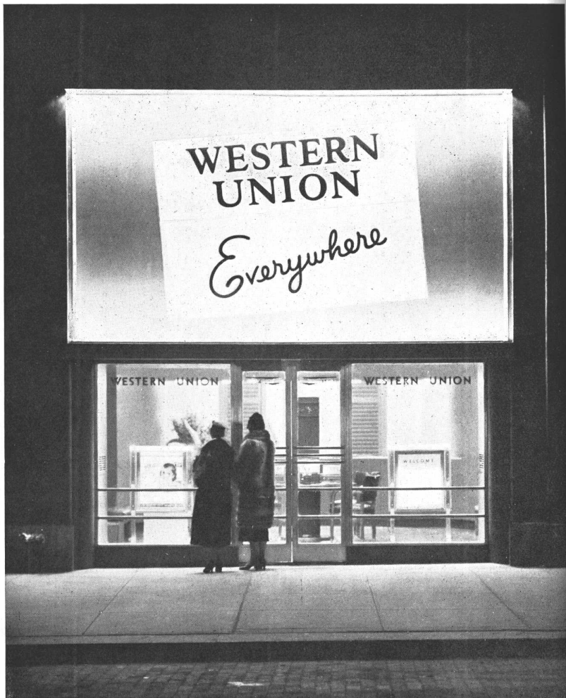
OFICINA DE LA WESTERN UNION, EN FILADELFIA. Una vista de la fachada. La parte superior, donde va la leyenda, es de aluminio y está iluminada de arriba y de abajo.
