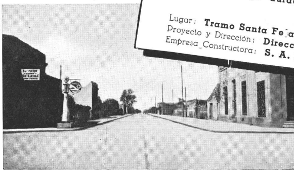
Calle Aufranc de Esperanza que forma parte del camino de hormigón que une a Santa Fe con Rafaela.
