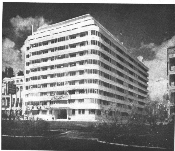
Embassy Court en Brighton, Inglaterra. Arq. Wells Coates. (De The Architectural Forum, Mayo 1937)
