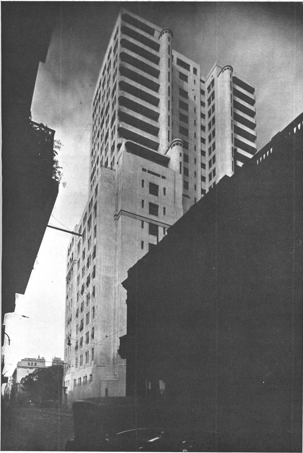
DIRECCION GENERAL DE ARQUITECTURA. Edificio para el Ministerio de Obras Públicas de la Nación Fachadas sobre las calles Moreno y Lima.
