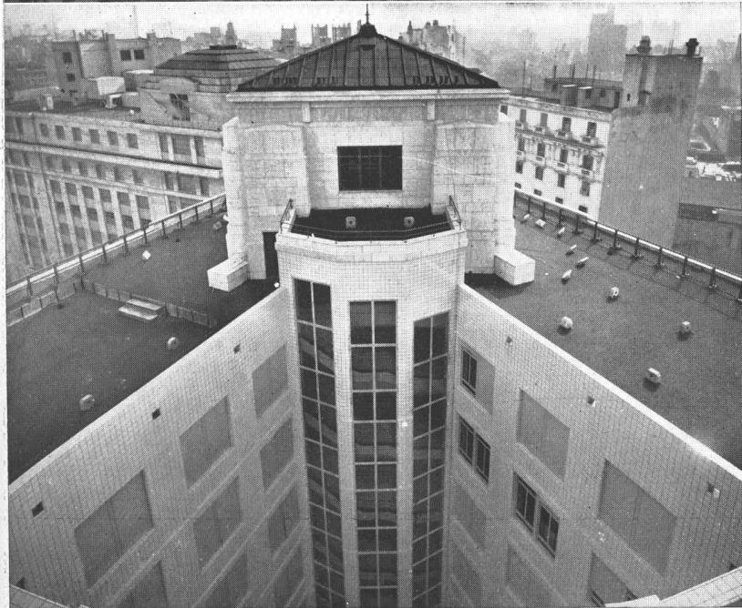
Arqs. Calvo, Jacobs y Gimenez - Arqs. consultores, Joseph, Londres. El nuevo edificio Shell Mex. ARRIBA, una vista del patio interior enteramente recubierto en mayólicas verdes para mejor difusión de la luz en el interior de las oficinas. ABAJO, azotea y torre de reloj
