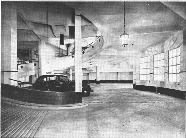
Arqs. Calvo, Jacobs y Gimenez - Arqs. consultores, Joseph, Londres. El nuevo edificio Shell Mex. ARRIBA, a la derecha el comienzo de la rampa que lleva al subsuelo de estacionamiento. AL MEDIO, el primer subsuelo y la rampa, ABAJO, otra vista del subsuelo de estacionamiento
