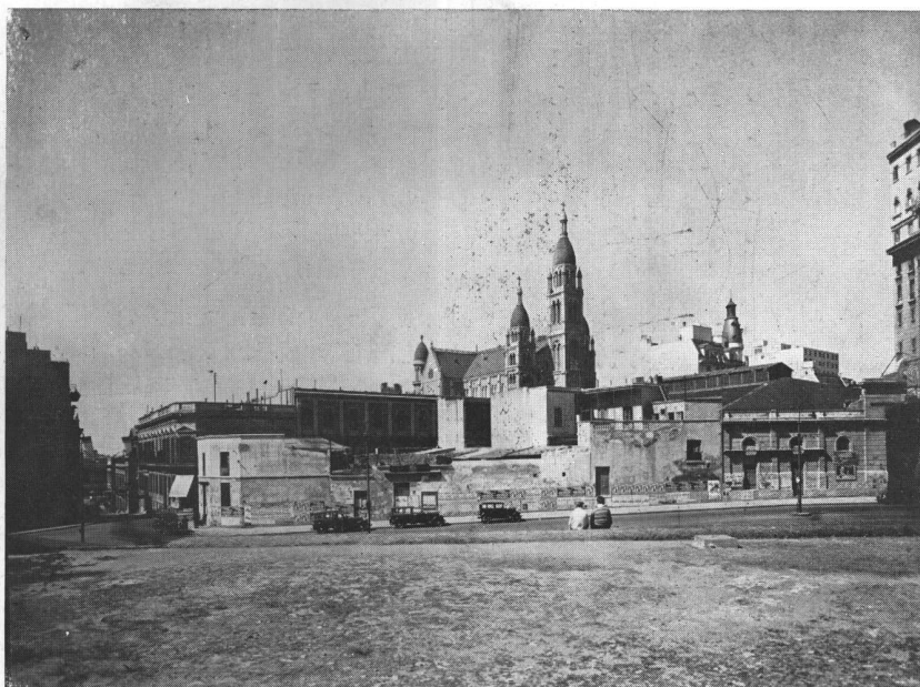
Aspecto que presentaban los terrenos que ocupa el edificio Kavanagh, antes de que se comenzara la construcción
