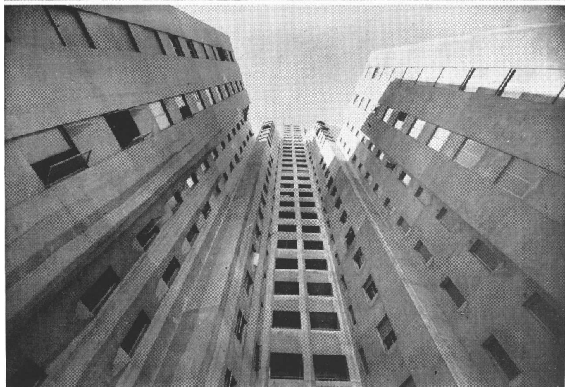
ARQS. SANCHEZ, LAGOS Y DE LA TORRE. Edificio Kavanagh. ARRIBA, una vista de la fachada. ABAJO, patio interior sobre Calle Nueva
