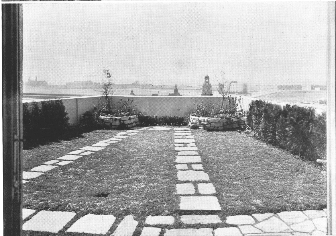
ARQS. SANCHEZ, LAGOS Y DE LA TORRE. Edificio Kavanagh. Dos grandes terrazas del piso 14. En la de arriba sobre el césped, se ha dispuesto un sendero cintrado con dos arriates que contienen árboles, arbustos rosales, cactus y otras plantas decorativas. ABAJO, sobre el fondo de césped, hay dos arriates y adelante un amplio sitio utilizable como pista de baile. Proyecto y realización de la Of. Tec. del Ing. Benito J. Carrasco.
