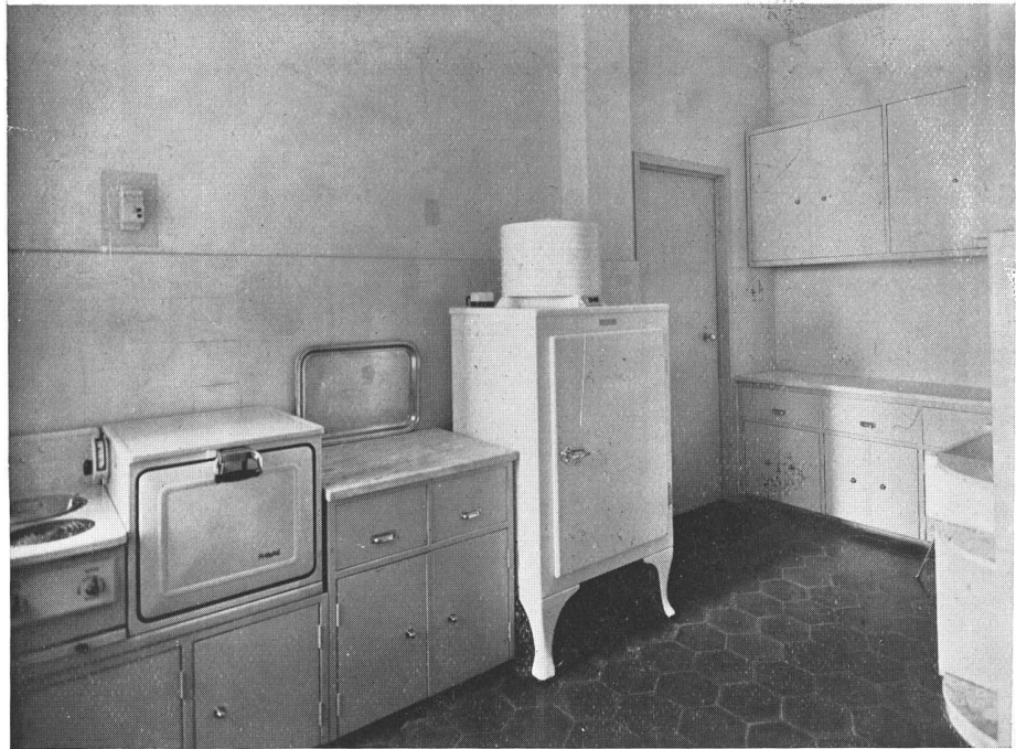
ARQS. SANCHEZ, LAGOS Y DE LA TORRE. Edificio Kavanagh. ARRIBA, departamento del Dr. Leonardo Grasso; detalle del dormitorio publicado en una página anterior. ABAJO, cocina y office; piso calcáreo exagonal verde cromo; paredes revestidas en azulejos chamota.
