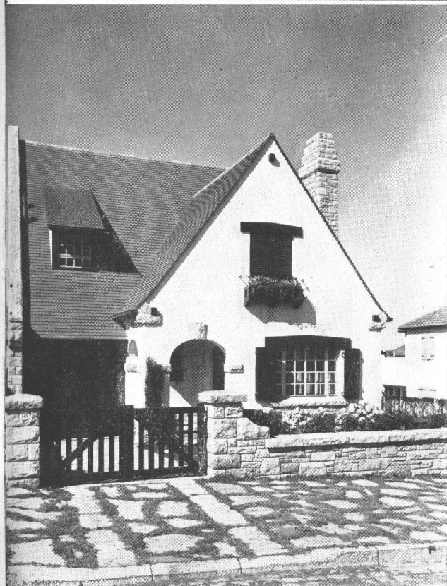
Constructora. Mar del Plata
