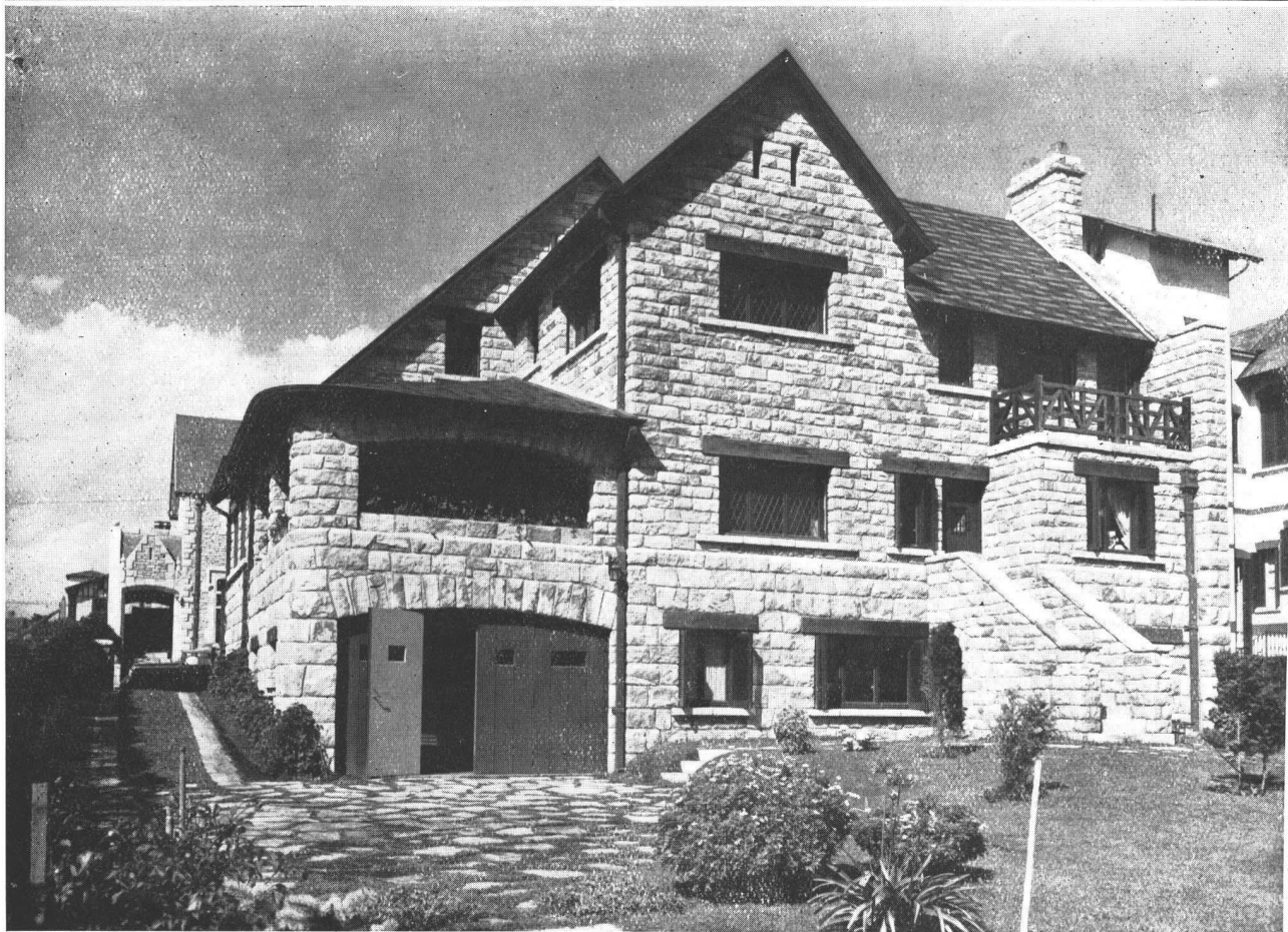
Proyecto del Sr. Amancio A. Williams, Dirección del Ing. Martín E. Biedma. - Chalet en Mar del Plata, propiedad del Sr. Alberto Williams. Las fachadas
