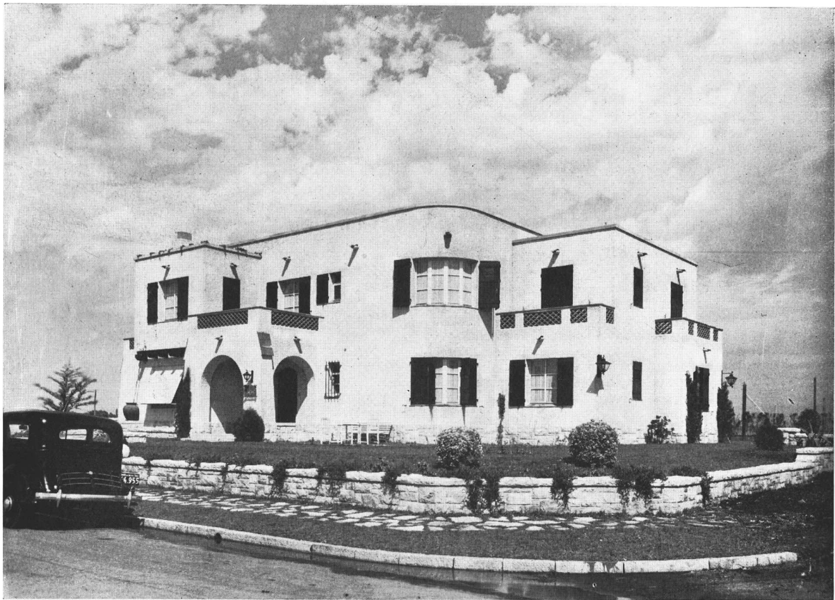
HOTEL "DE NEDERLANDEN" del Sr. E. H. M. PETERSEN Arquitecto: LUIS ABERASTAIN ORO Empresa Constructora: SARTORA e HIJOS Córdoba 2628 - U. T. 1206 - Mar del Plata
