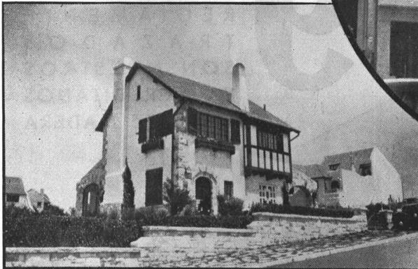
En las calles Rawson y A. del Valle, se levanta el chalet que muestra la fotografía, propiedad del Sr. Carlos Grether. Fué proyectado por los Arqs. Sres. Aberastain Oro y Dudley y construído por los Sres. Sartora e Hijos. ↓
