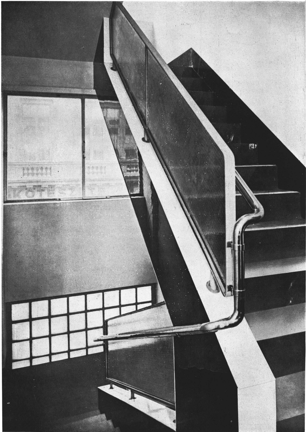
Ludwig Kozma, Budapest. La Casa de Vidrio. Escalera de hormigón armado, revestida de linoleo y vidrio; barandilla de vidrio armado.
