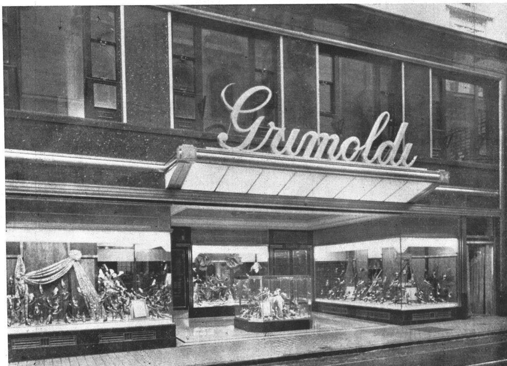
Obra Grimoldi, Suipacha 367 - Arq. A. y A. J. Olivari
