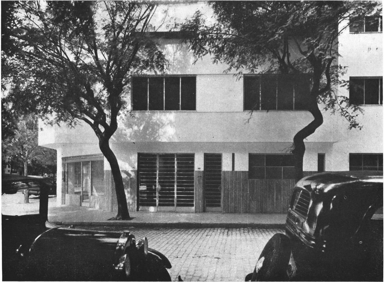
DETALLE DE FACHADA
