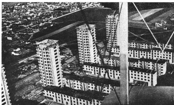
Bloc de alojamientos medianos para empleados en Praga. Libra y Kan, Arqs. (De Batir, Febrero 1935)
