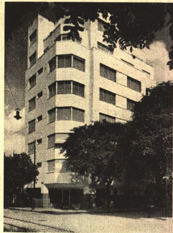
La construcción del edificio Ugar- teche 3083, esquina Cabello, ha estado a carga de esta empresa.
