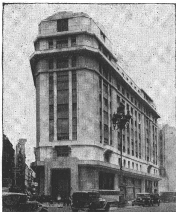
EDIFICIO «VOLTA» Arq. A. Bustilo 10 Baños de color
