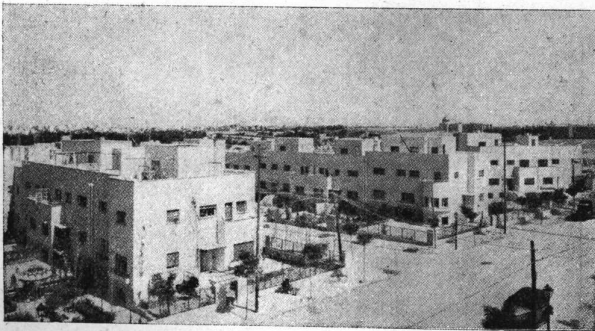
Vista de la barriada de casas económicas "El Viso" en Madrid, Arq. Bergamin (De Nuevas Formas, Nº 4, 1934)
