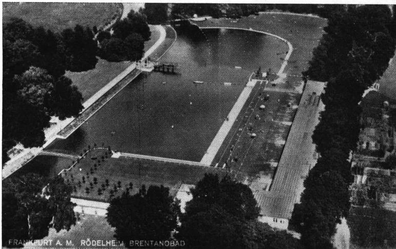
Fig. 27 FRANKFURT s/m. - Baños públicos del Parque Brentano.
