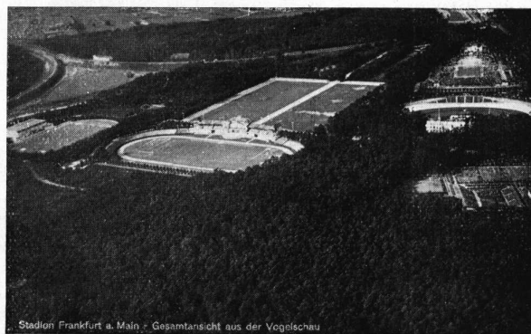
Stadion Frankfurt a. Main. Gesamtansicht aus der Vogelschau
