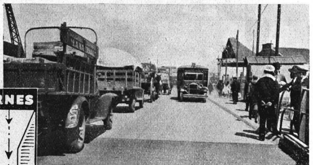
Y fué así como empleando 'INCOR', se pudo habilitar al tránsito, un pavimento de hormigón, a las pocas horas de construido.
