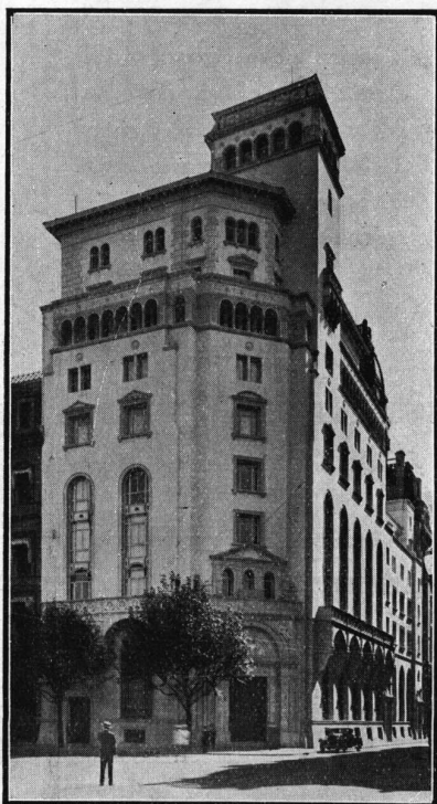
En el Nuevo Banco Italiano se han instalado enfriadores de agua dual-automáticos Westinghouse del tipo CMT-4
