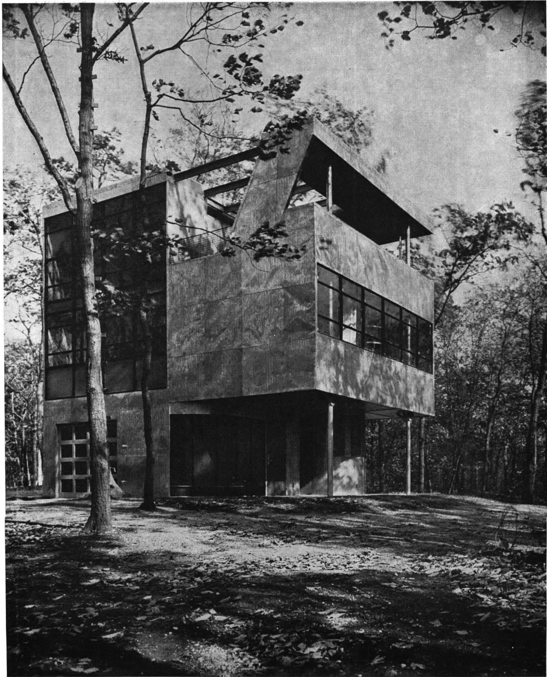
La casa terminada en aluminio. - Se ven dos de las seis delgadas columnas de aluminio de 0,10 que sostienen toda la construcción. El gran ventanal del costado sobre el garage corresponde a un extremo del living-room y la azotea que es en parte techada y en parte descubierta es uno de los sitios más agradables de la vivienda
