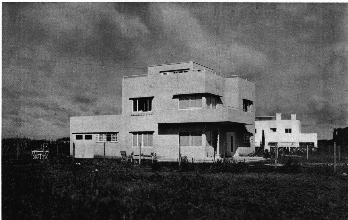
Vista de la fachada Noreste
